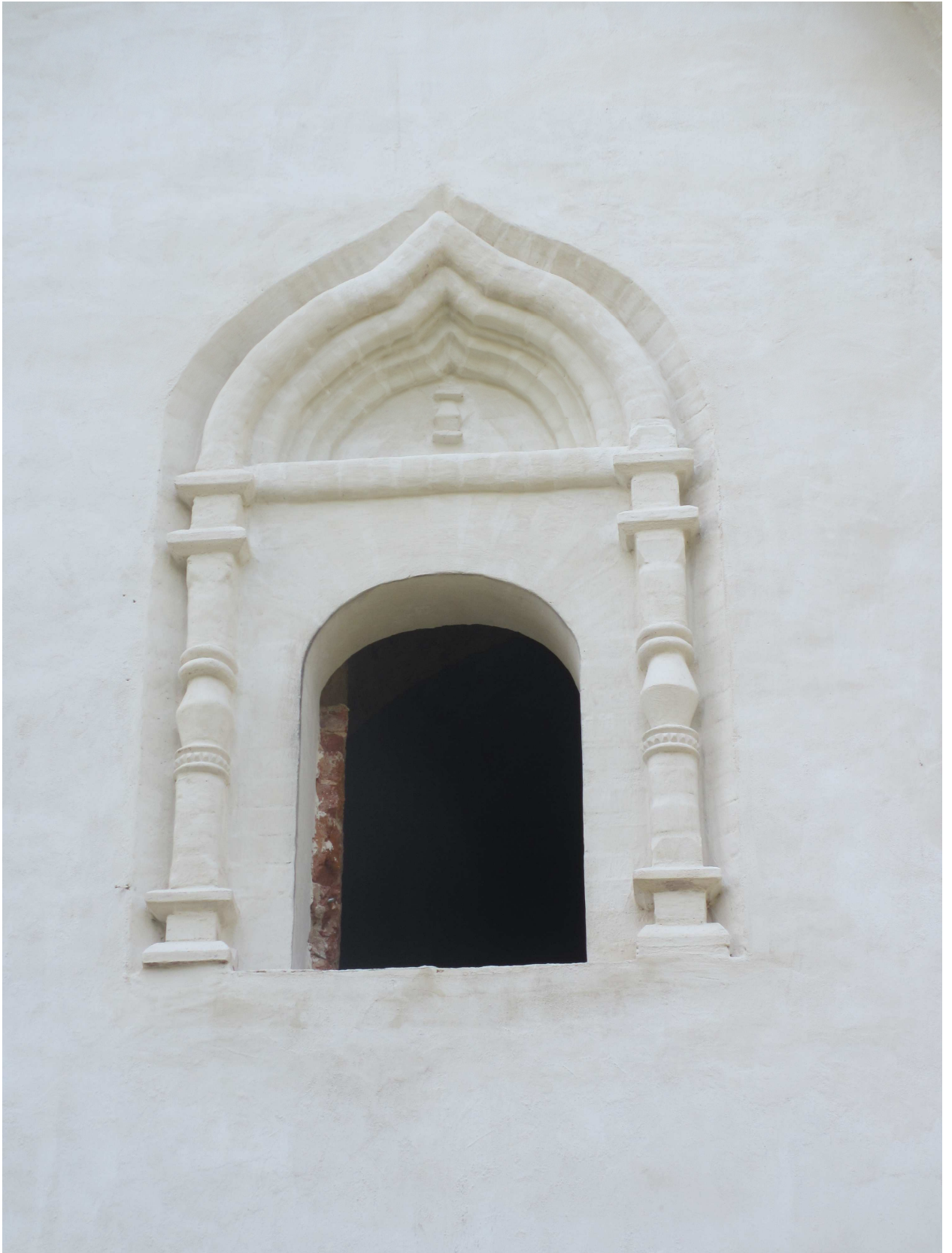
Рис. 2.6. Троицкий собор Троицкого Зеленецкого монастыря. Наличник оконного проема южного фасада. Фото автора. 2014 г.
