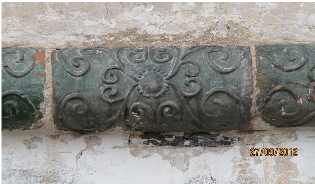
Рис. 2.34. Фасадный изразец (карнизный валик) Троицкого собора Зеленецкого монастыря. Фото 2011 г.
