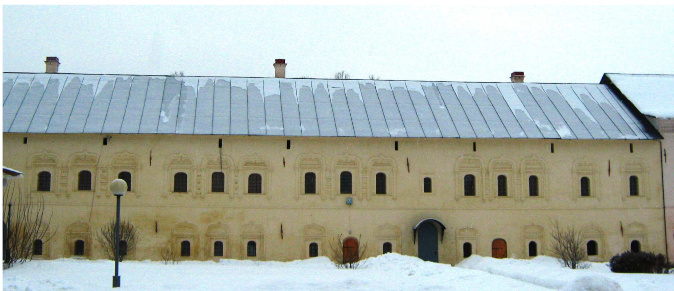
Рис. 3.10. Продухи в верхней (чердачной) части келейных корпусов. Успенский Тихвинский монастырь. Южные кельи. Фото 2013 г.
