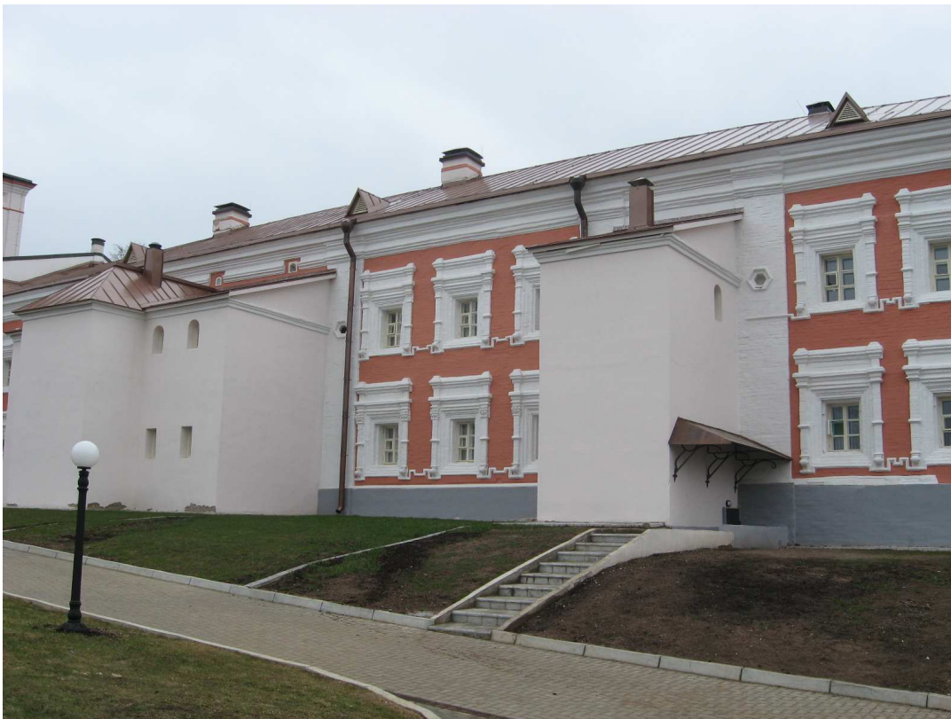
Рис. 4.14. Валдайский Иверский монастырь. Воссоздание пристроек братского корпуса. Фото 2007 г.
