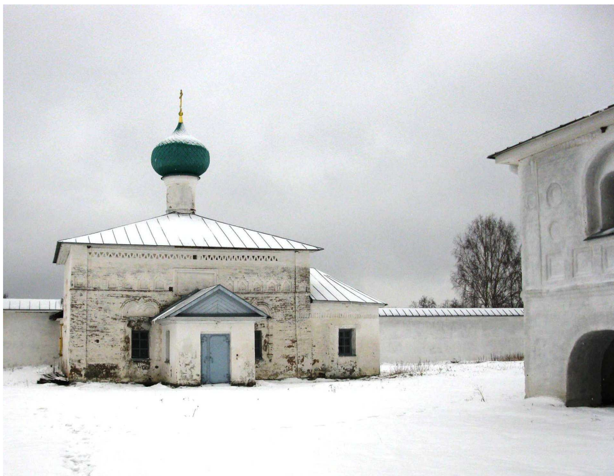
Рис. 3.32. Больничная церковь Иоанна Дамаскина Александро-Свирского Троицкого монастыря. Фото 2014 г.
