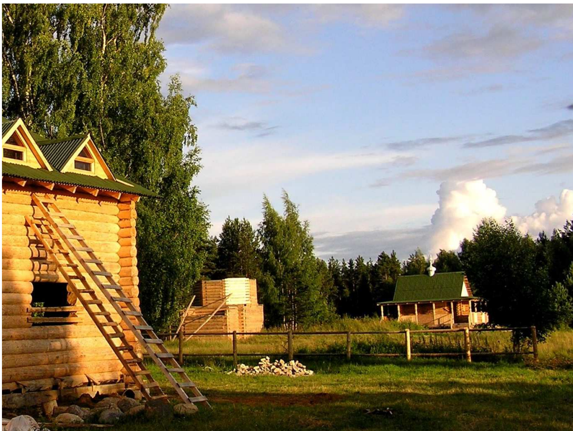
Рис. 4.3. Синозерская пустынь (Вологодская область), процесс воссоздания. Фото 2009 г.
