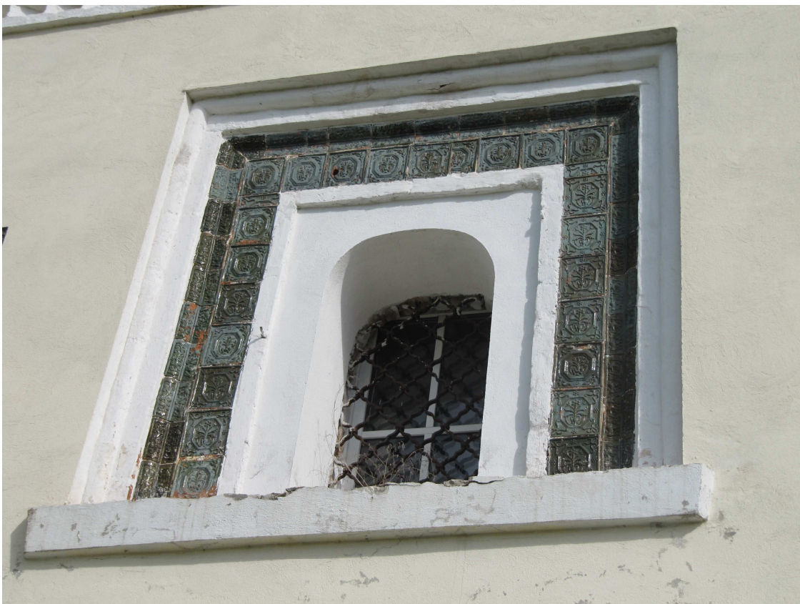
Рис. 2.36. Наличник оконного проема трапезной палаты Троицкого Зеленецкого монастыря. Фото 2010 г.
