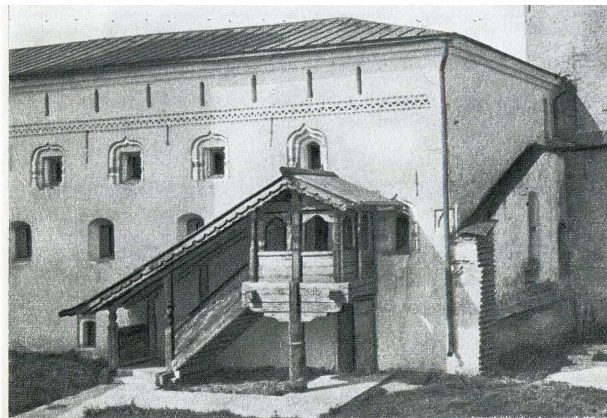
Рис. 2.42. Новгород. Детинец. Корпус Владычного двора. М.К. Каргер. Новгород. Памятники архитектуры XI – XVII веков. Л., 1975. С.106.
