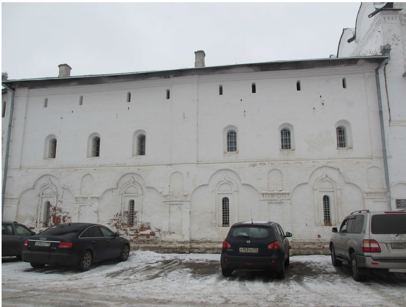
Рис. 3.9. Продухи в верхней (чердачной) части келейных корпусов. Кельи западной ограды Спасо-Прилуцкого монастыря. Фото 2014 г.
