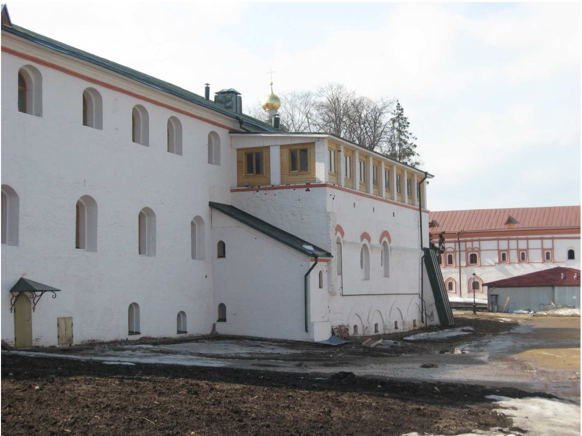
Рис. 4.17. Валдайский Иверский монастырь. Устройство холла перед конференц-залом над историческими хозяйственными помещениями трапезной палаты. Фото 2007 г.
