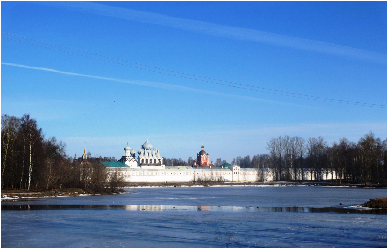
Рис. 4.21. Успенский Богородичный монастырь в Тихвине. Воссоздание пятиглавого завершения Крестовоздвиженской церкви – одновременно и градостроительное воссоздание городской доминанты. Фото 2014 г.
