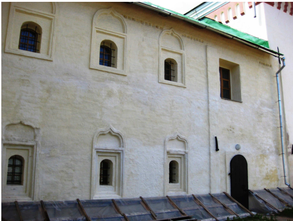
Рис. 3.31. Успенский Тихвинский монастырь. Больничные кельи с церковью апостола Андрея Первозванного. Фрагмент восточного фасада. Фото 2012 г.
