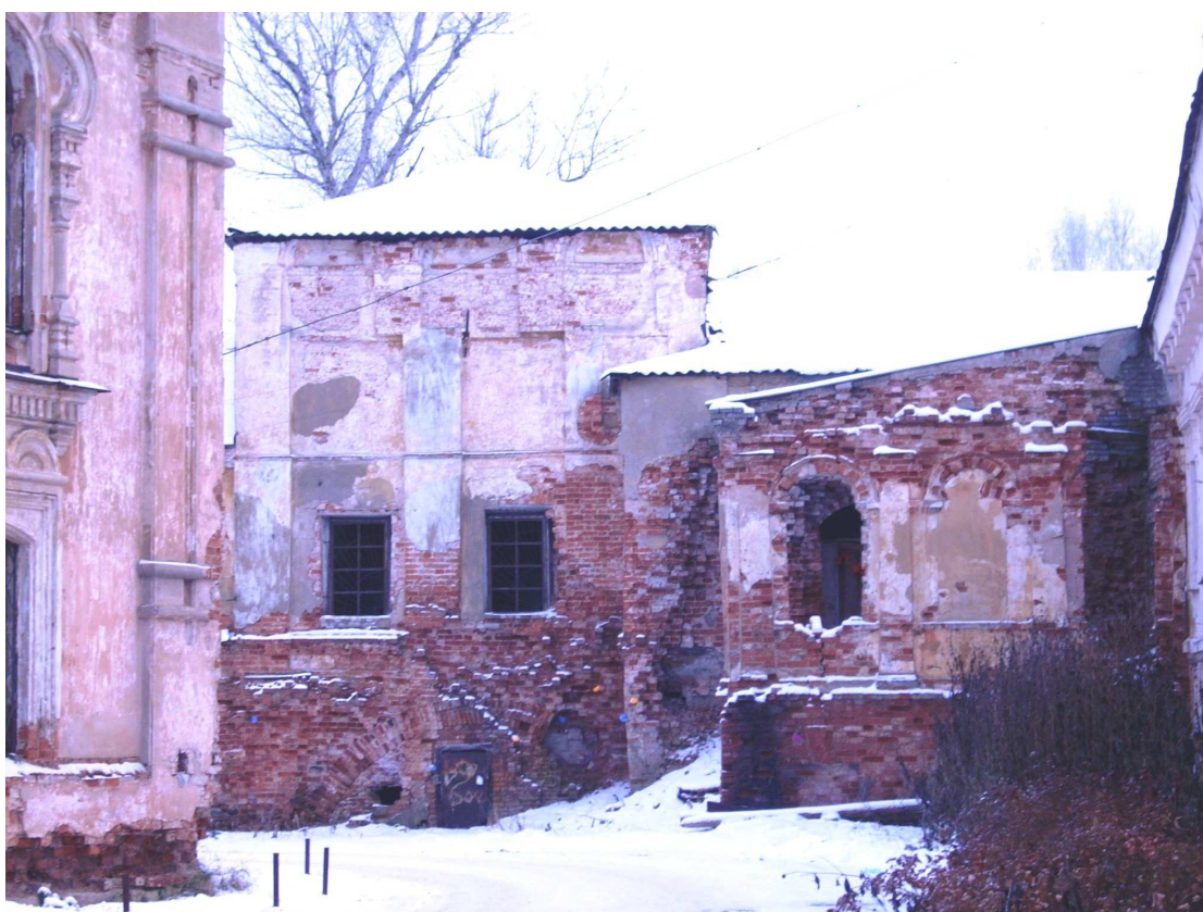
Рис. 2.25. Сбивка лопаток в верхней части северного фасада церкви Рождества Богородицы трапезной палаты Введенского Тихвинского монастыря. Фото Е. Варакина, 2008 г.
