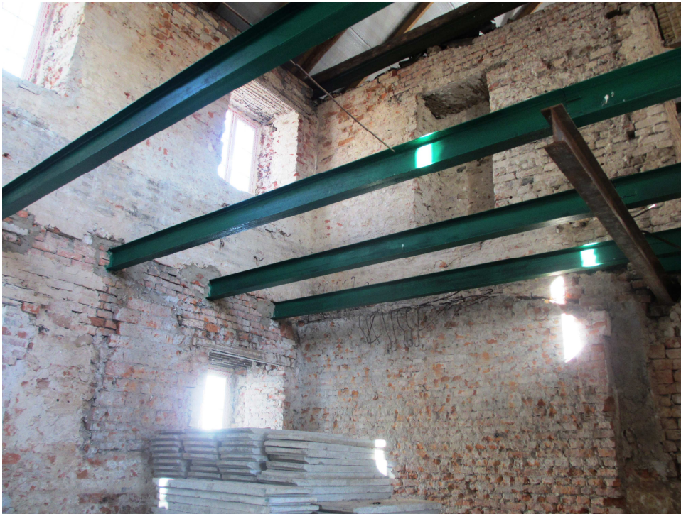
Рис. 4.13. Внедрение новых конструкций при приспособлении келейных корпусов Александра-Свирского Троицкого монастыря. Фото 2014 г.
