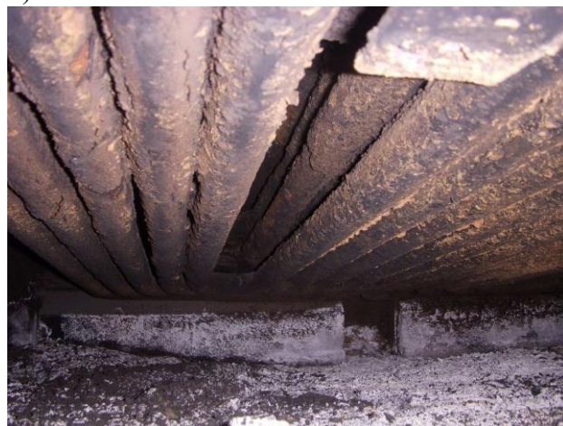
Рис. 5. Изображения: а) – левая сторона труб №1 рядов №7–9 конвективных пакетов котла КВу-1,0 №2; б) – нижние трубы конвективного пакета котла КВ-ГМ-2,0 (вид из зольника)
