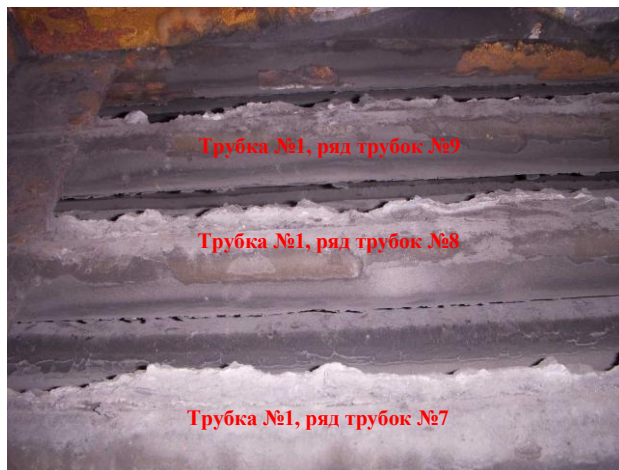
Рис. 5. Изображения: а) – левая сторона труб №1 рядов №7–9 конвективных пакетов котла КВу-1,0 №2; б) – нижние трубы конвективного пакета котла КВ-ГМ-2,0 (вид из зольника)
