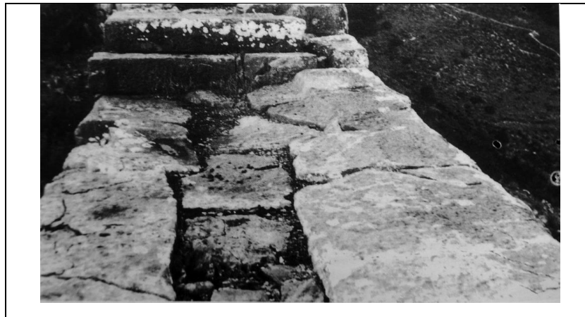
Рисунок 2.3.27. Фрагмент крепостной стены в восточной части Приеныс так называемым «parodos» - верхнему парапету стен.
