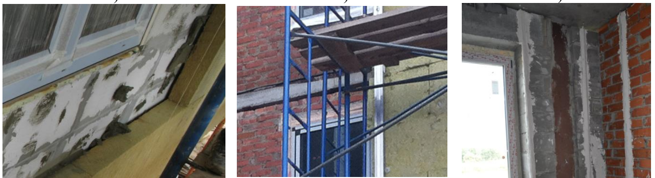
Рисунок 2.2 – Нарушение технологии устройства основания:
