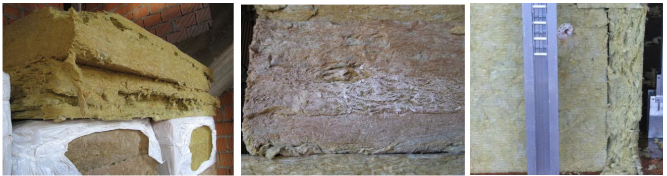
Рисунок 2.1 – Использование материалов с пониженными теплозащитными характеристиками:
