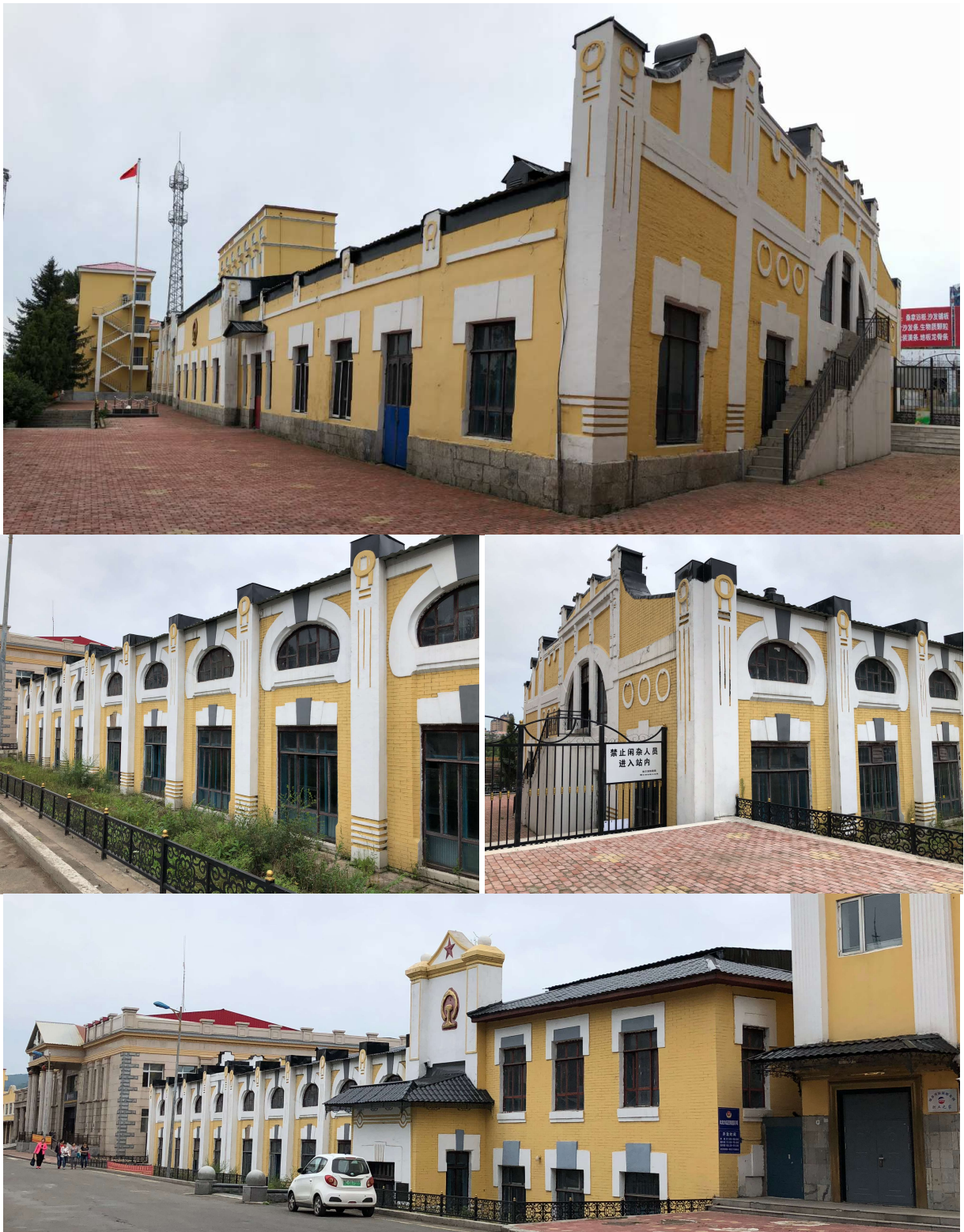
Рисунок 19 – Работа с наследием в Суйфэньхэ – адаптация под новые функции здания вокзала (фасады со стороны путей, города и фрагменты) (фотография автора, 2018 г.)
