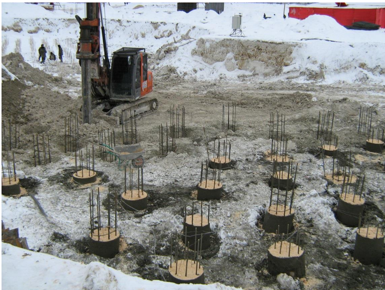
Рисунок 1.5 – Фрагмент выполненного свайного поля из свай в пробитых скважинах с уширением на площадке строительства
