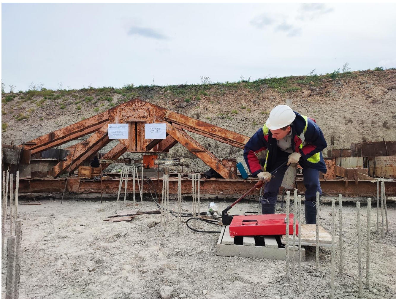
Рисунок 2.12 – Фрагмент статических испытаний
