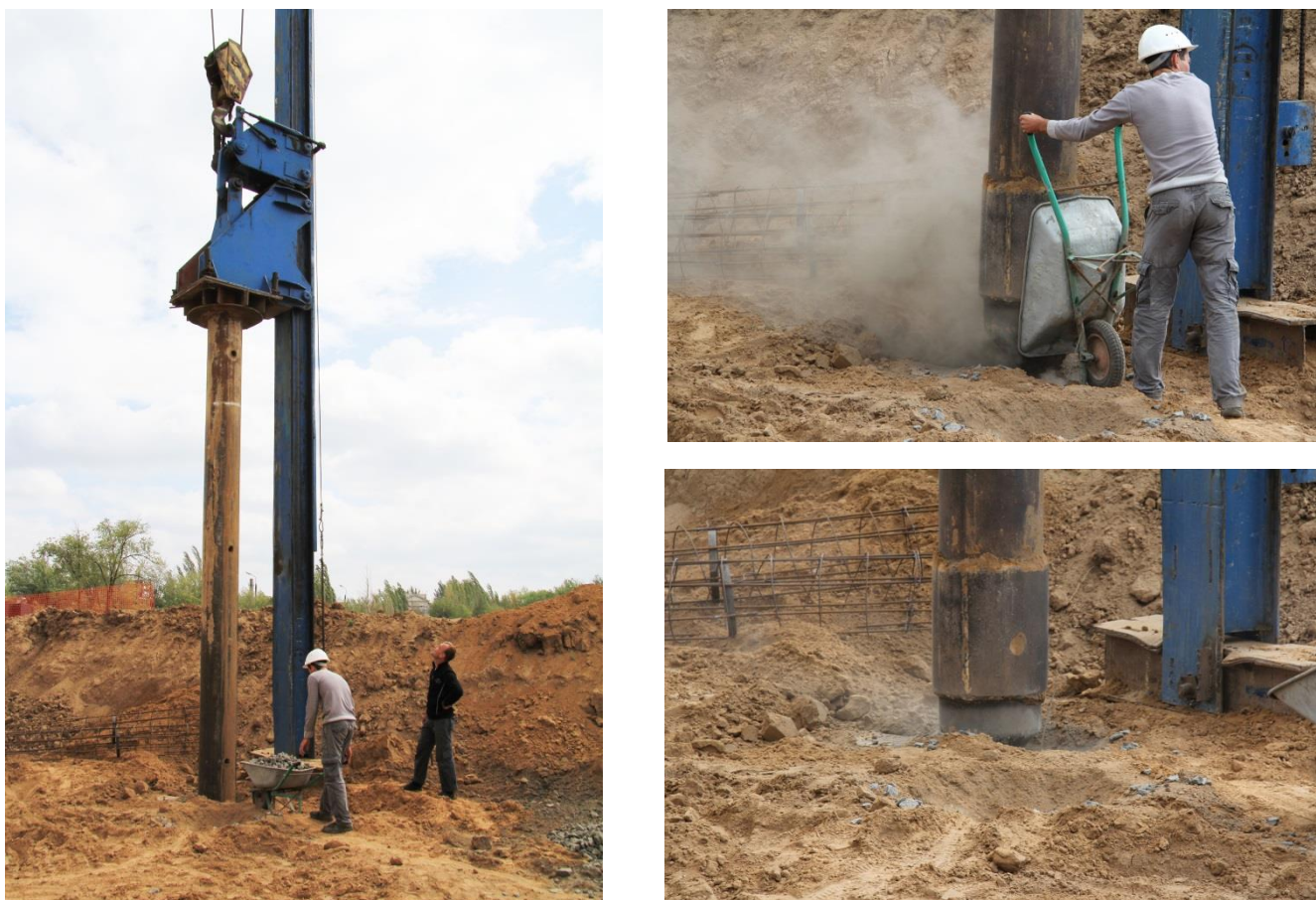
Рисунок 1.4 – Формирование уширения: порционная засыпка щебня в скважину с последующим сбрасыванием трамбовки
