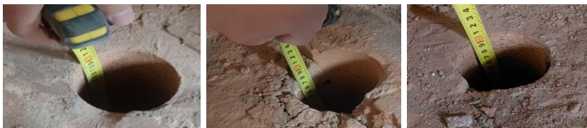
Рисунок 15. Результаты измерения толщины кирпичной кладки в каждом своде
