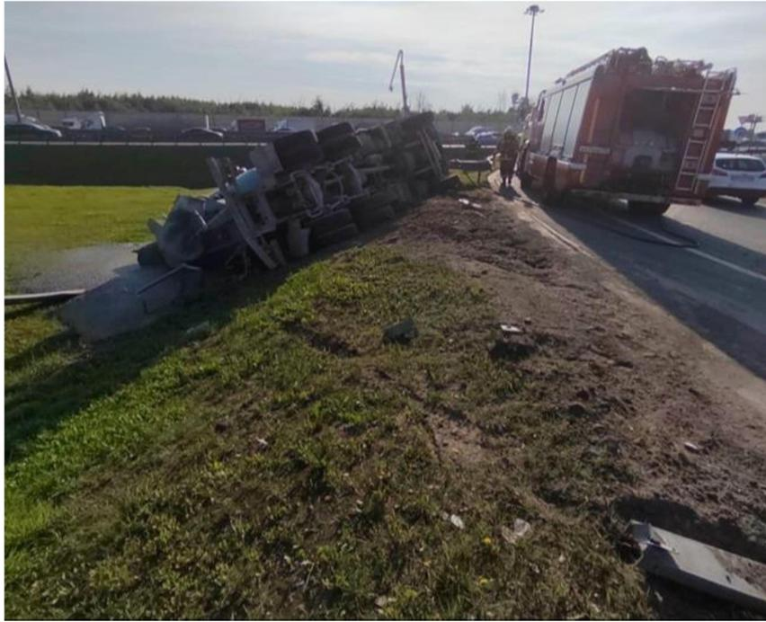
Рисунок 1.14 - 100% разрушение барьерного ограждения. Консольные стойки полностью отсутствуют на проектных отметках
