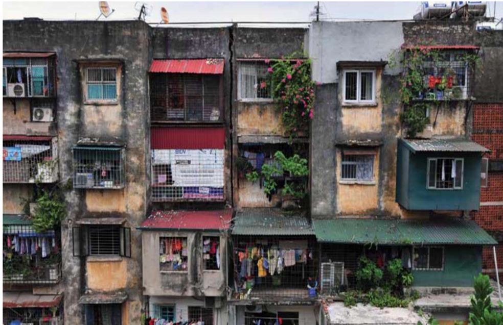
Рисунок 1.1. Фото зданий на улице в столице Ханое Вьетнама ( vn.sonomu.vn - 17/01/2023), как образец труднодоступности для обследования несущих конструкций
