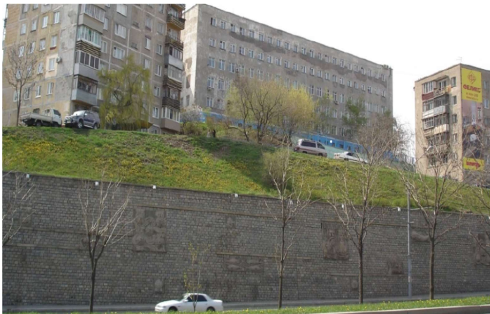
Рисунок 1.2. Подпорная стена для удержания грунтовой массы ( stroiznania.ru – 03/01/2025)
