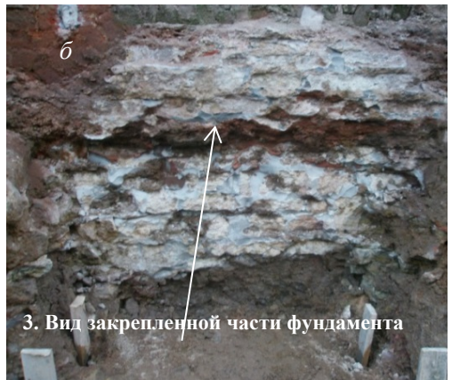
Рис. 16. Восстановление несущей способности бутового фундамента укрепительной цементацией: а – схема укрепления тела фундамента; б – вид закрепленного фундамента в шурфе (видны наплывы закрепляющего цементного раствора); 1 – иньектор для нагнетания закрепляющего раствора; 2 – бутовый фундамент; 3 – закрепленная часть фундамента; 4 – массив закрепленного грунта в зоне расположения деревянных лежней под подошвой фундамента
