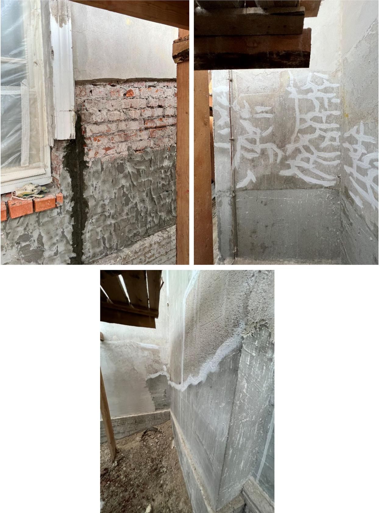
Рисунок 5.3 – Устройство санитарного покрытия над цокольной облицовкой (2023 г.)
