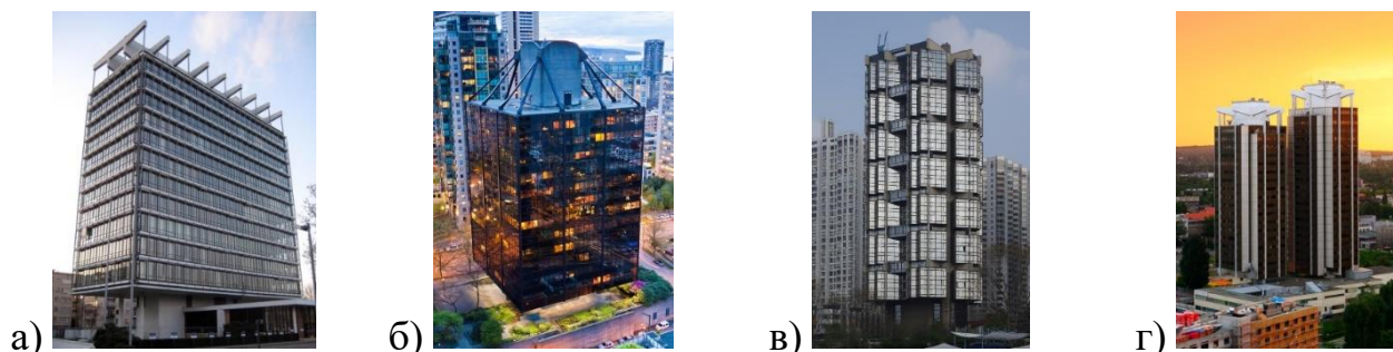
Рисунок 1.9 – Возведённые ствольно-подвесные здания: а) BP Building; б) Qube; в) Tour Totem; г) Stalexport
