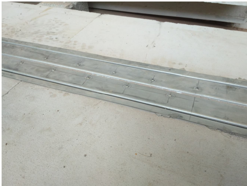
Рисунок 2.5 – Устройство дополнительных анкерных креплений листов профиля с помощью забивных дюбелей
