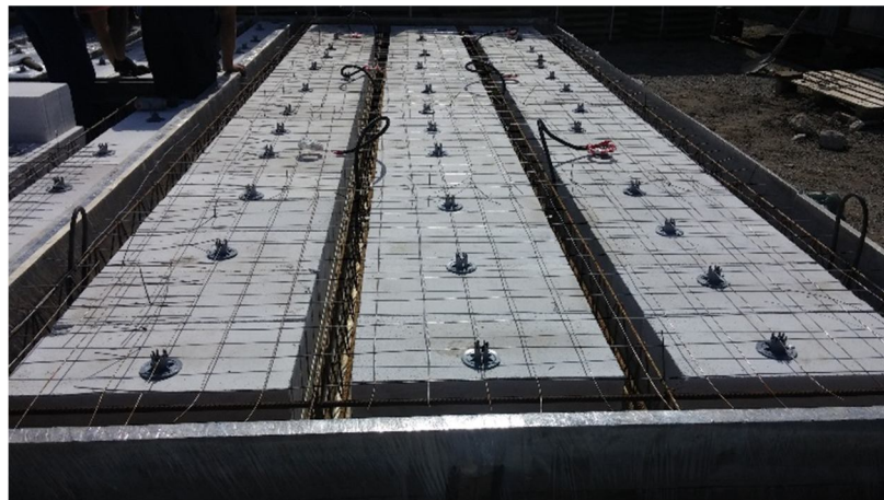
Рисунок 2.2 – Изготовление балок (общий вид)
