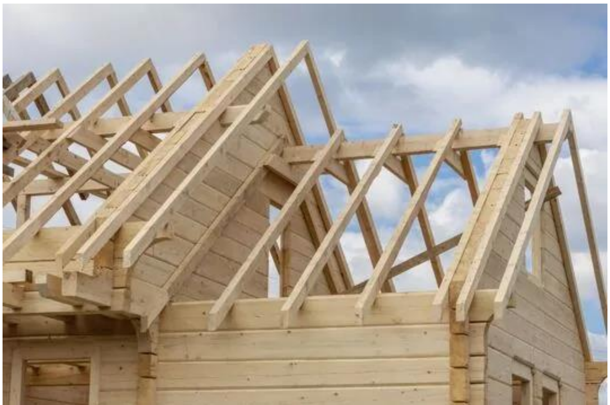
Рисунок 1.2 – Балки из LVL при устройстве стропильной системы (фото с официального сайта ООО «Невские конструкции»)
