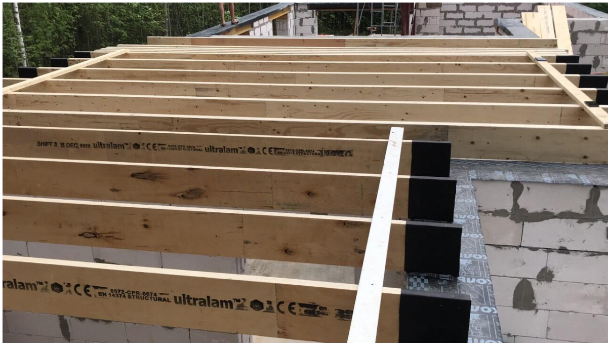
Рисунок 1.1 – Балки из LVL при устройстве междуэтажного перекрытия
