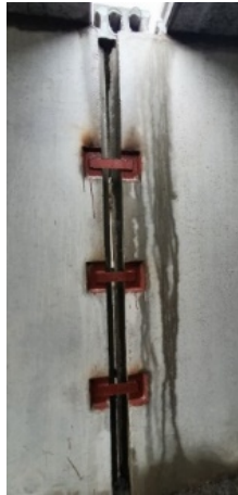
Рисунок 1 – Упругоподатливый узел
