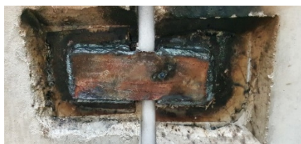
Рисунок 4 – Сварное соединение пластин
