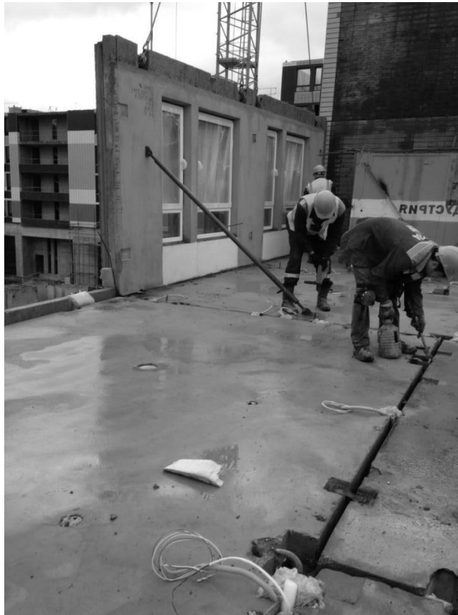
Рисунок 1.4 – Подъем наружной стеновой панели
