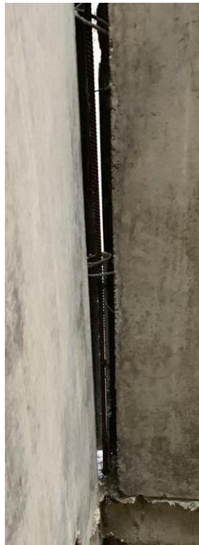
Рисунок 1.11 – Узел соединения стеновых панелей до этапа омоноличивания.
