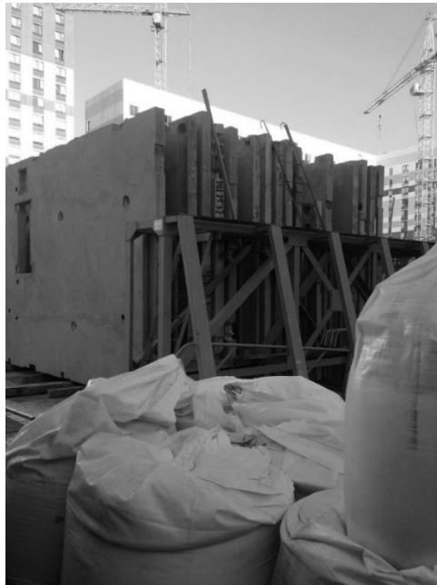
Рисунок 1.3 – Складирование панелей в «кассетах».
