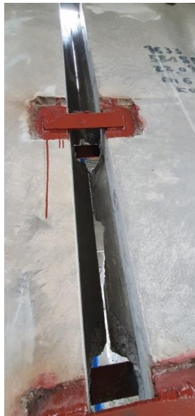
Рисунок 1.8 – Обработка монтажных закладных деталей антикоррозионным составом.
