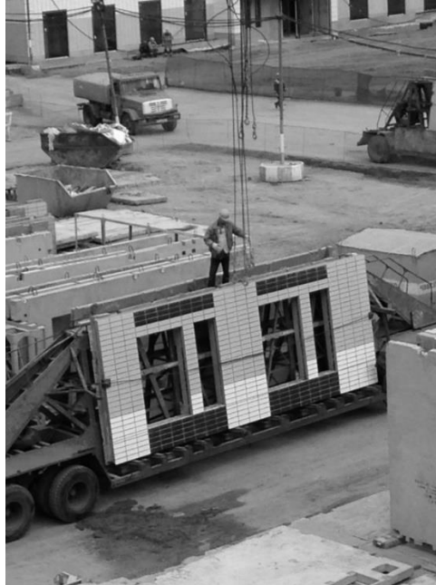
Рисунок 1.2 – Монтаж стеновых панелей с колес транспортного средства.
