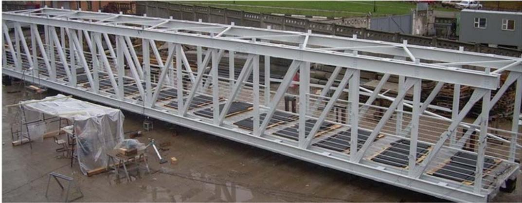
Рисунок 10. Фотография пролётной конструкций пешеходного моста над 2-ым Карачаровским проездом, г. Москва [90].
