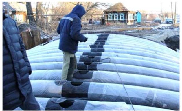
Рисунок 11. Фотографии автомобильного однопролётного арочного моста в районном поселении Языково Ульяновской области [76].
