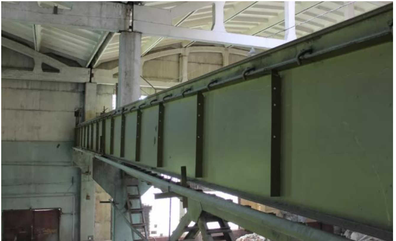
Рисунок 2.5. Вид подкрановой балки вдоль здания
