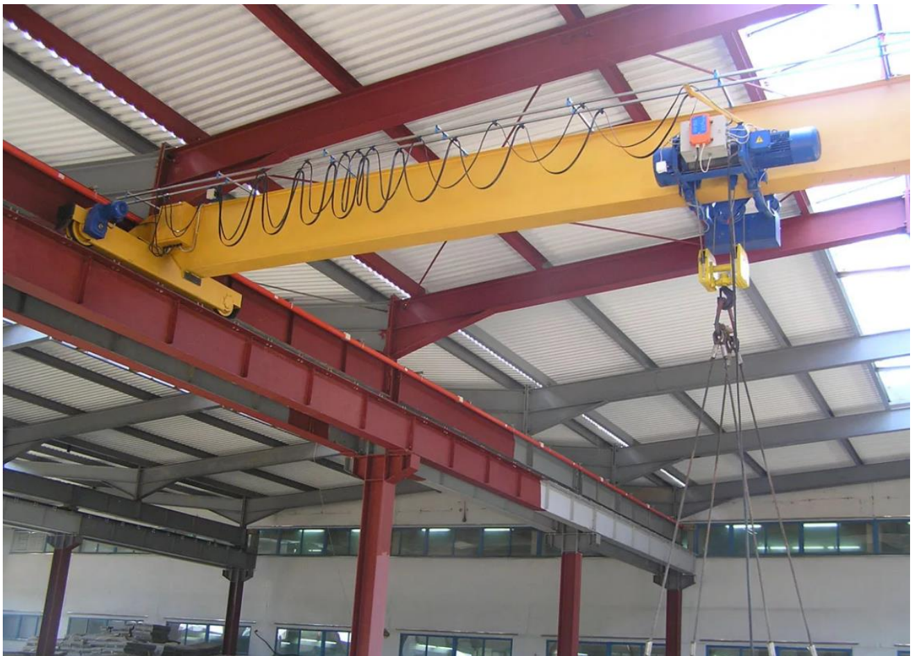
Рисунок 2.4. Общий вид цеха с подкрановыми балками и мостовым краном
