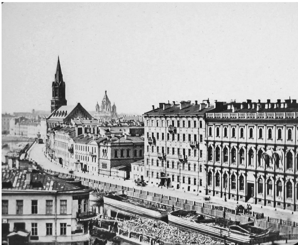
36. Вид вдоль Мойки . б/д /. https://www.citywalls.ru/photo575451.html/
