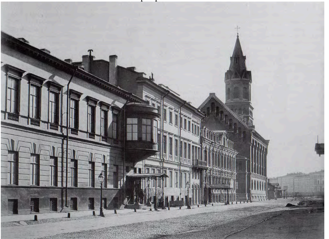
39. Вид на немецкую реформаторскую церковь вдоль Большой Морской улицы. 1865 г. /. https://www.citywalls.ru/house1487.html
