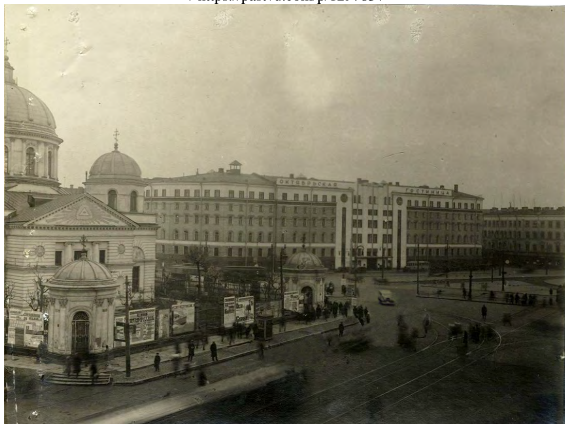
21. Вид на Знаменскую церковь и площадь Восстания с балкона дома на Невском проспекте. 1938 г. / https://pastvu.com/p/1246873/ /
