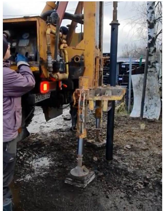
Рис. 4.15. Процесс вдавливания свай.
