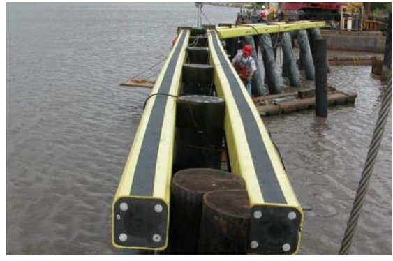
Рис. 1.17. Производство SRP-свай – а, б [47] и их применение – в, г [139]
