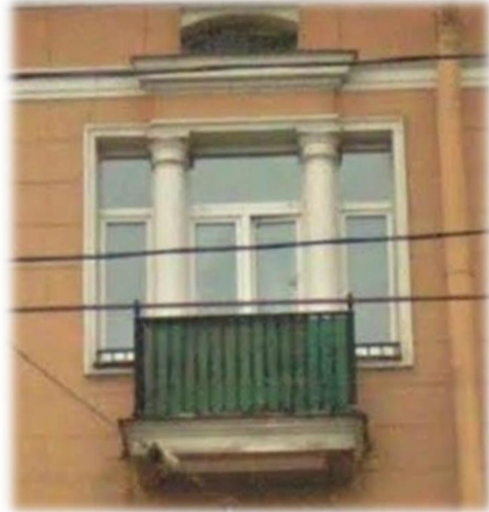
Тип 17. Образец оформления балконной двери с сандриком и полуколоннами дорического ордера. Дверное и оконные заполнения не сохранились
