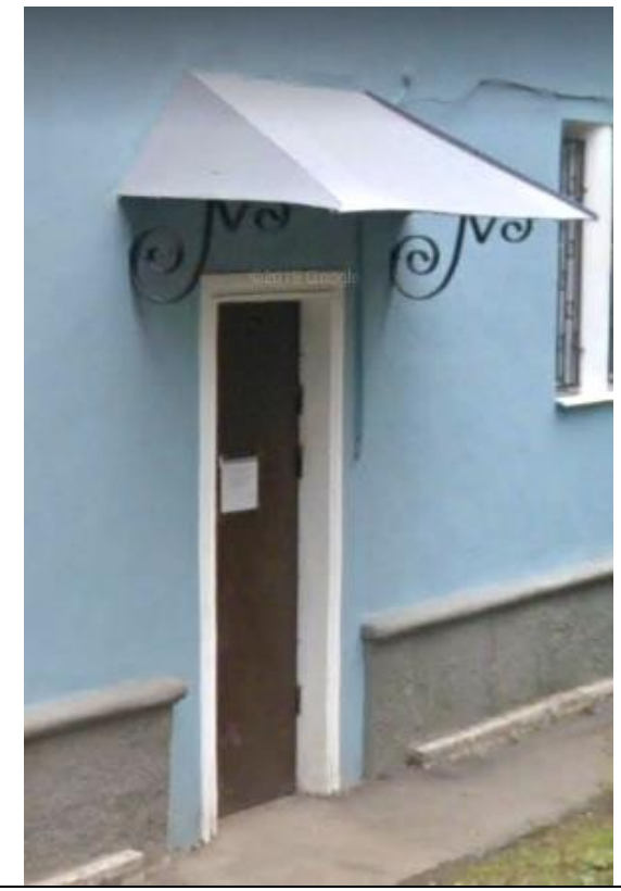
Тип 3. Образец оформления входа (конструкция и покрытие козырька изменено)
