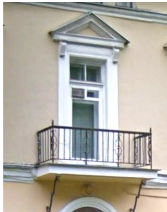
Тип 11. Образец оформления сандрика с фронтоном на кронштейнах. Использован проект жилого дома, разработанного для комплекса на проспекте Стачек.
