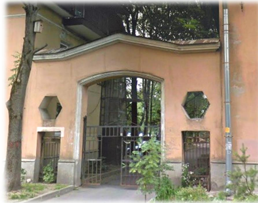
Тип 2. Образцы оформления соединительных арок. В своей структуре предусматривают разделение транспортных (центральный проезд) и пешеходных (боковые проходы) потоков.
