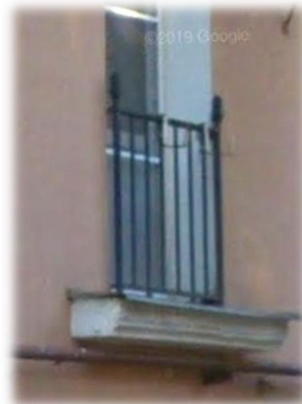
Тип 11. Балкон. Металлическое, кованое ограждение.
