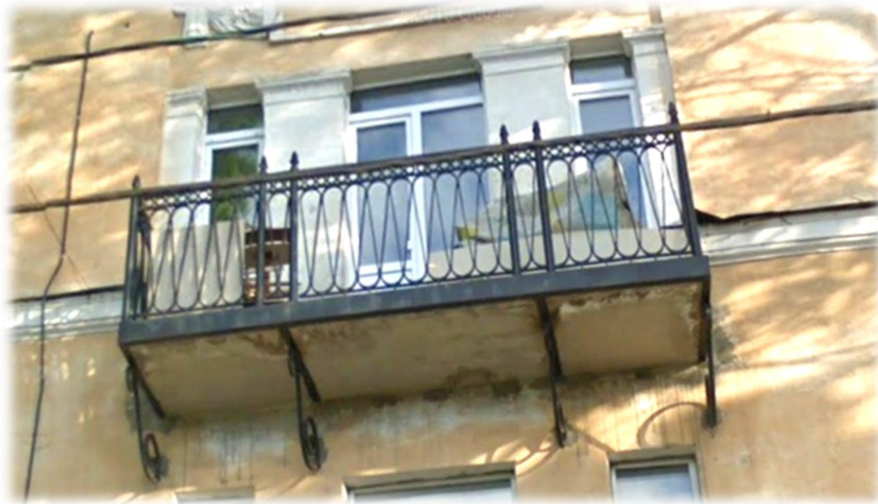
Тип 9. Балкон на декоративных кованых кронштейнах. Металлическое, кованое ограждение
