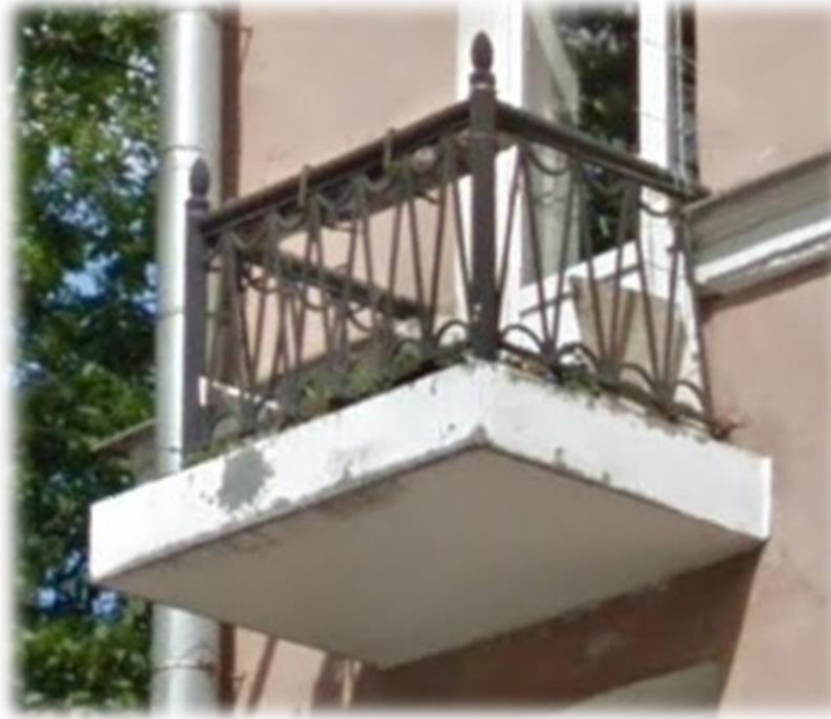
Тип 5-2. Балкон. Металлическое, кованое ограждение.
