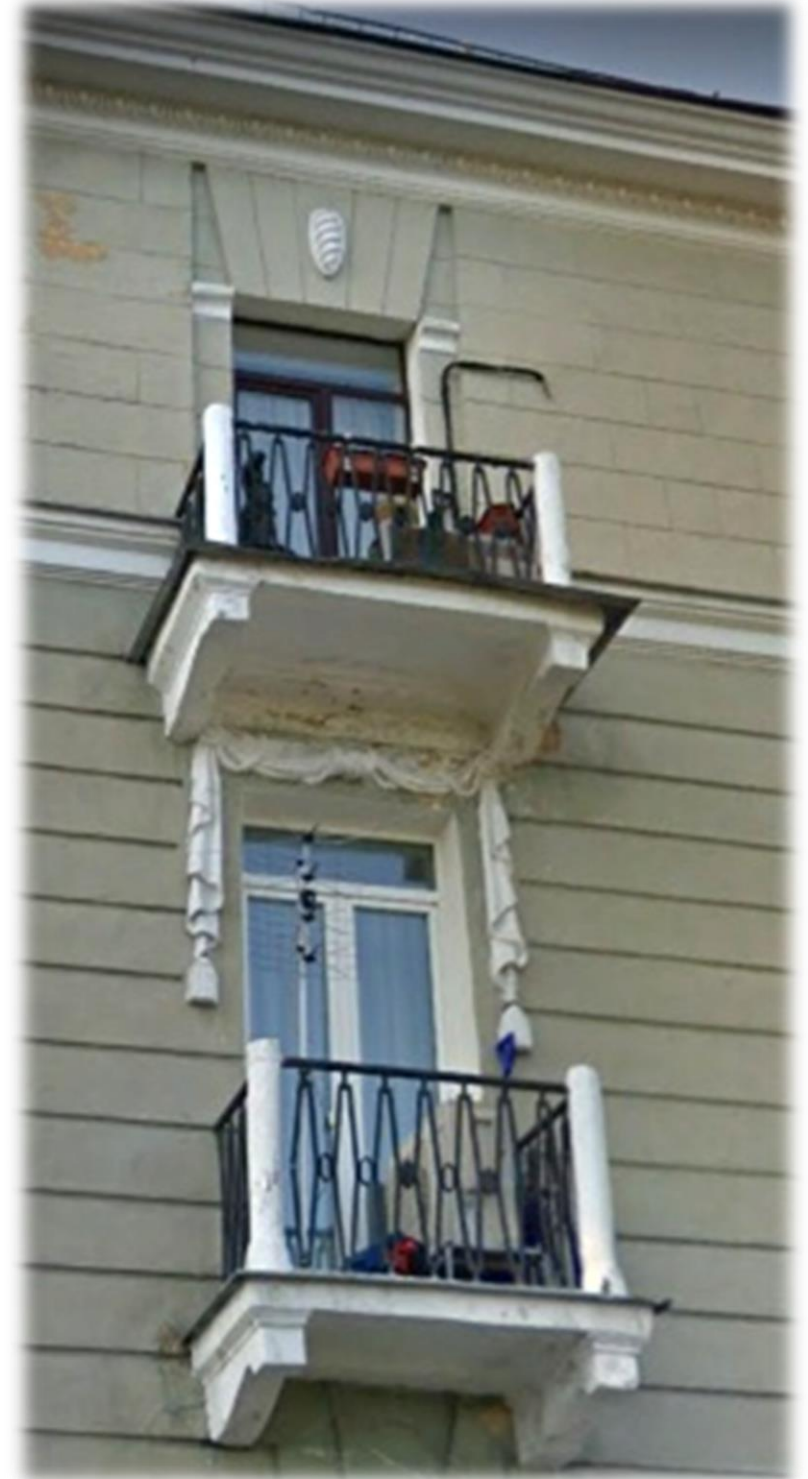
Тип 9-2. Балкон. Металлическое, кованое ограждение. Использован гипсовый декор.
