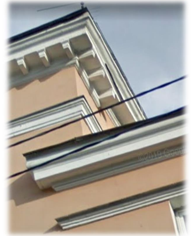
Тип 11. Образец оформления венчающего профилированного карниза на кронштейнах
