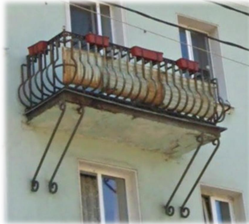
Тип 6. Балкон на декоративных кованых кронштейнах. Металлическое, кованое ограждение.
