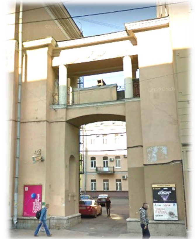
Тип 36. Арочный проем, предусматривающие транспортный проезд и пешеходный проход во внутриквартальное пространство.
