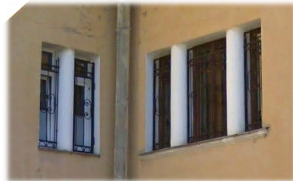
Тип 4. Образец оформления окон с колоннами. Оконные заполнения не сохранились
