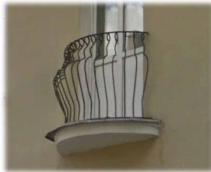
Типы 5-1; 12. Балкон. Металлическое, кованое ограждение.
