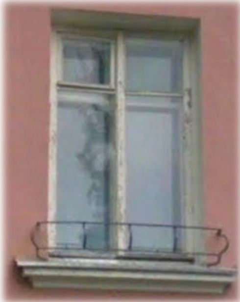
Тип 5. Образец оформления подоконного карниза с металлической, кованой конструкцией для устройства цветов в кадках.
