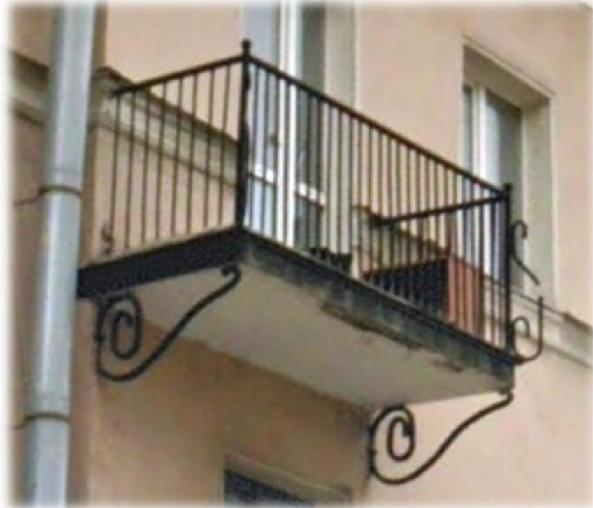
Тип 10-1. Балкон. Металлическое, кованое ограждение.
