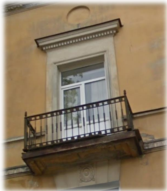
Тип 18. Образец оформления балконной двери с сандриком и контраличиком. Дверное заполнение не сохранилось
