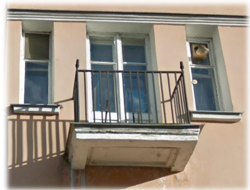
Тип 10. Балкон на декоративных кованых кронштейнах. Металлическое, кованое ограждение.
