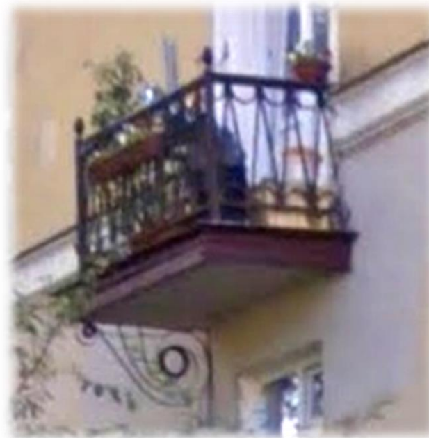
Тип 8. Балкон на декоративных кованых кронштейнах (кронштейн сохранился в 1 экз.). Металлическое, кованое ограждение.
