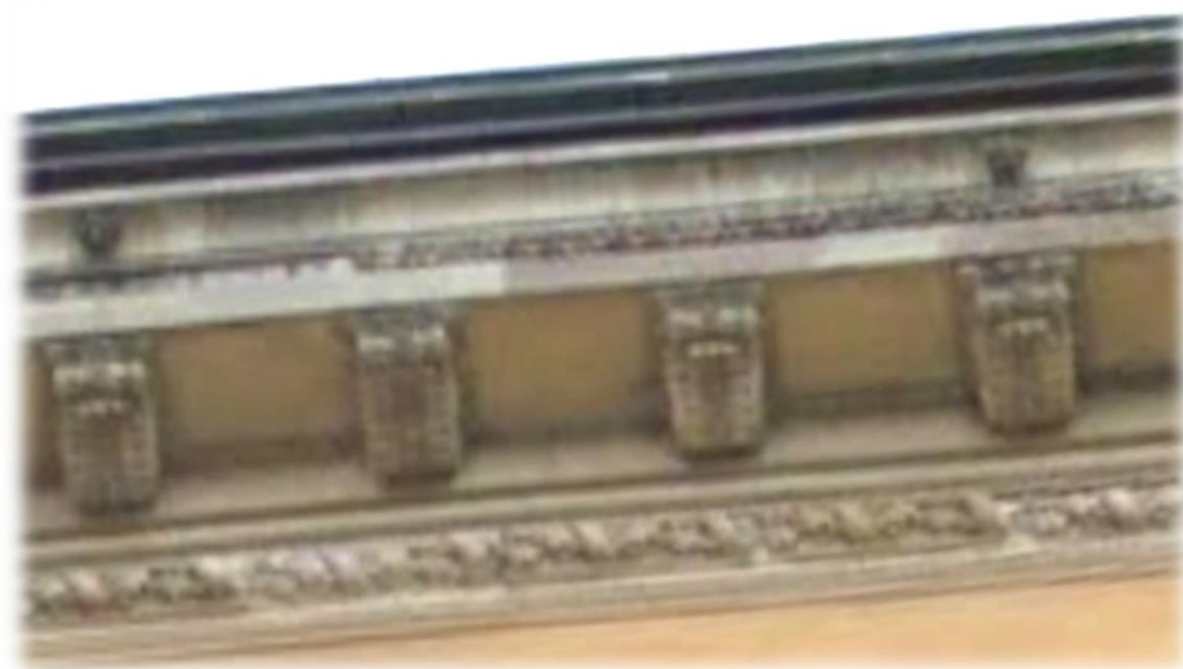
Тип 18. Профилированный, декорированный карниз на горизонтальных кронштейнах
