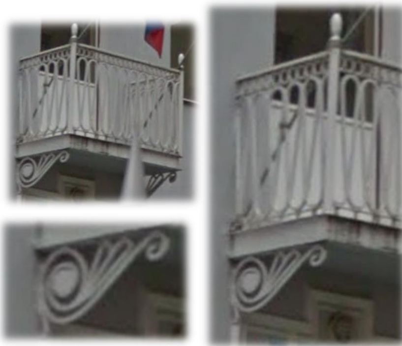
Тип 1-2. Балкон. Металлическое, кованое ограждение.
