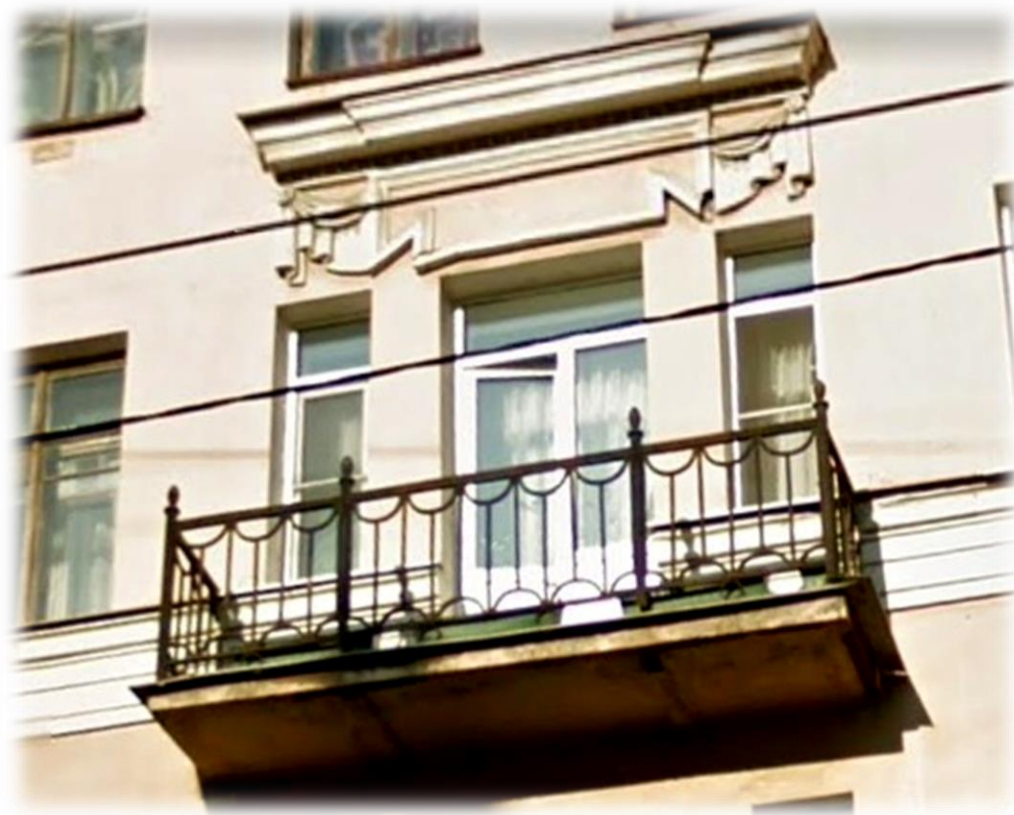
Тип 36. Балкон. Металлическое, кованое ограждение.
