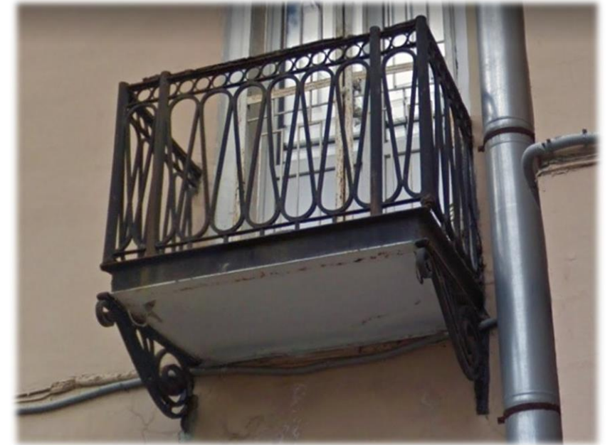
Тип 4. Главный фасад. Балкон. Металлическое, кованое ограждение.
