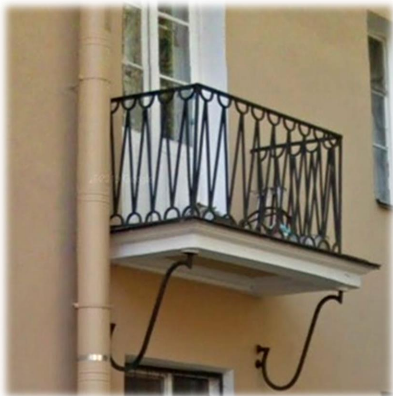
Тип 2. Балкон на декоративных кованых кронштейнах. Металлическое, кованое ограждение.
