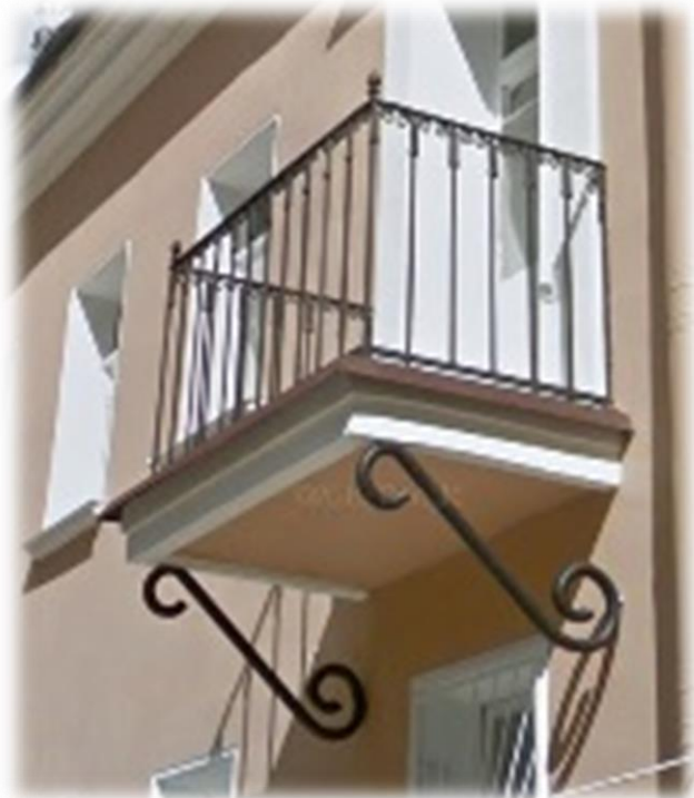
Тип 2. Боковой фасад. Балкон. Металлическое, кованое ограждение.
