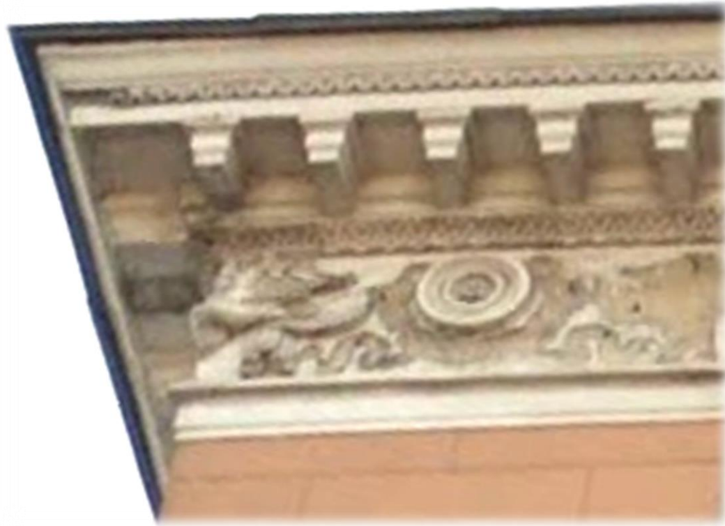
Тип 19. Профилированный карниз с модульонами или кронштейнами и декоративным рельефом в составе антаблемента.
