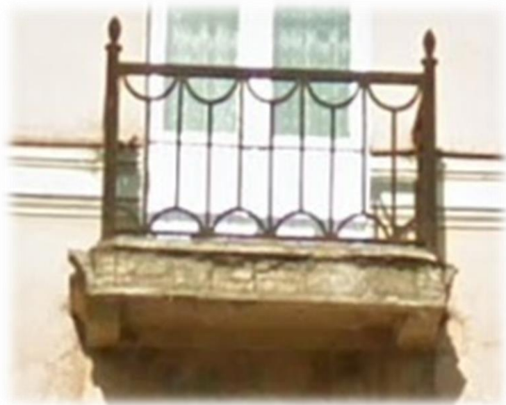
Тип 36. Балкон. Металлическое, кованое ограждение.
