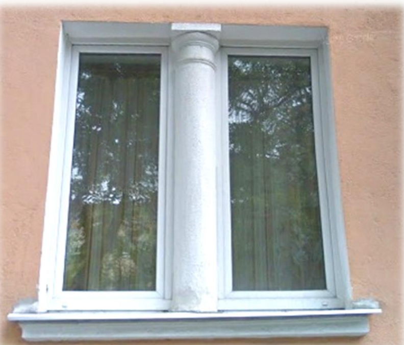
Тип 17. Образец оформление окна с полуколонной дорического ордера. Оконные заполнения не сохранились.
