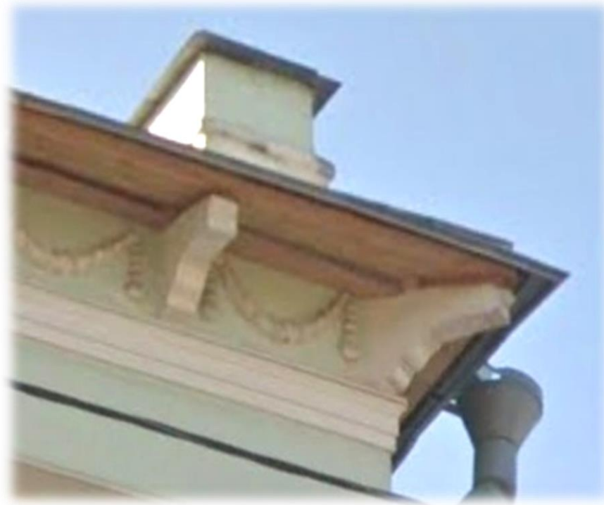
Тип 6. Образец оформления венчающего карниза на кронштейнах, с использованием декоративных лепных композиций (гирлянды) в составе антаблемента.
