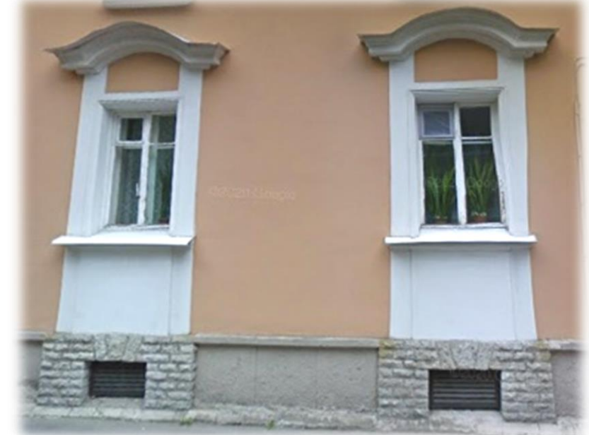
Тип 7. Образец оформления окна с наличником, сандриком и подоконным парапетом. Цокольное окно оформлено в каменной кладке с частичной разбивкой на клинья.
