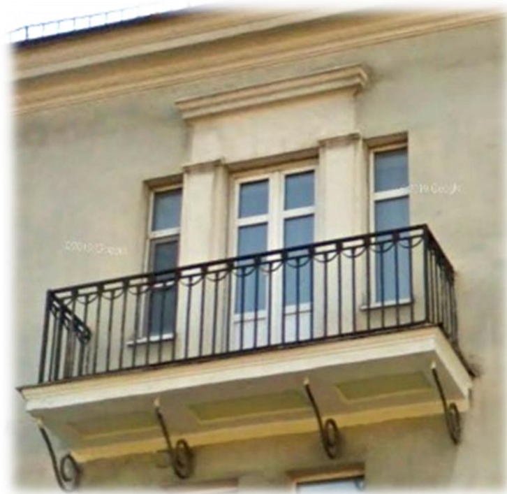
Тип 16. Образец оформления балконной двери с сандриком и лопатками. Балкон с кованым ограждением на кованых, декоративных кронштейнах. Дверное и оконные заполнения не сохранились.
