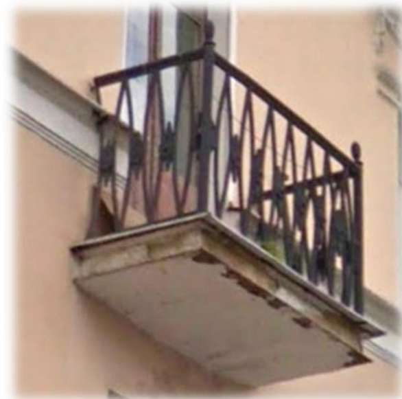
Тип 28. Балкон. Металлическое, кованое ограждение.
