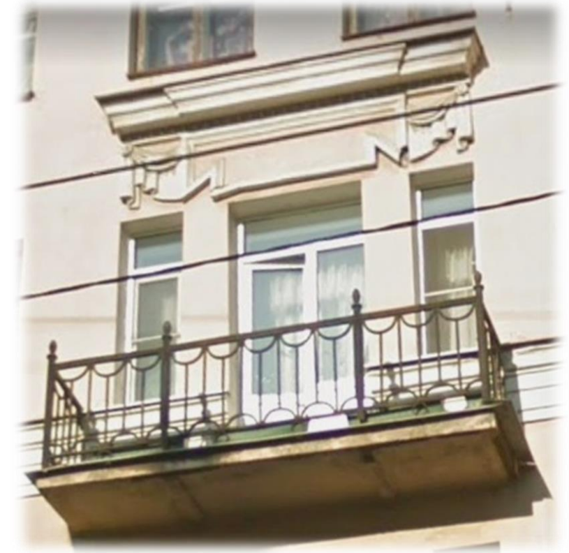
Тип 36. Образец оформления балконной двери и окон с сандриком и декоративной лепной композицией.
