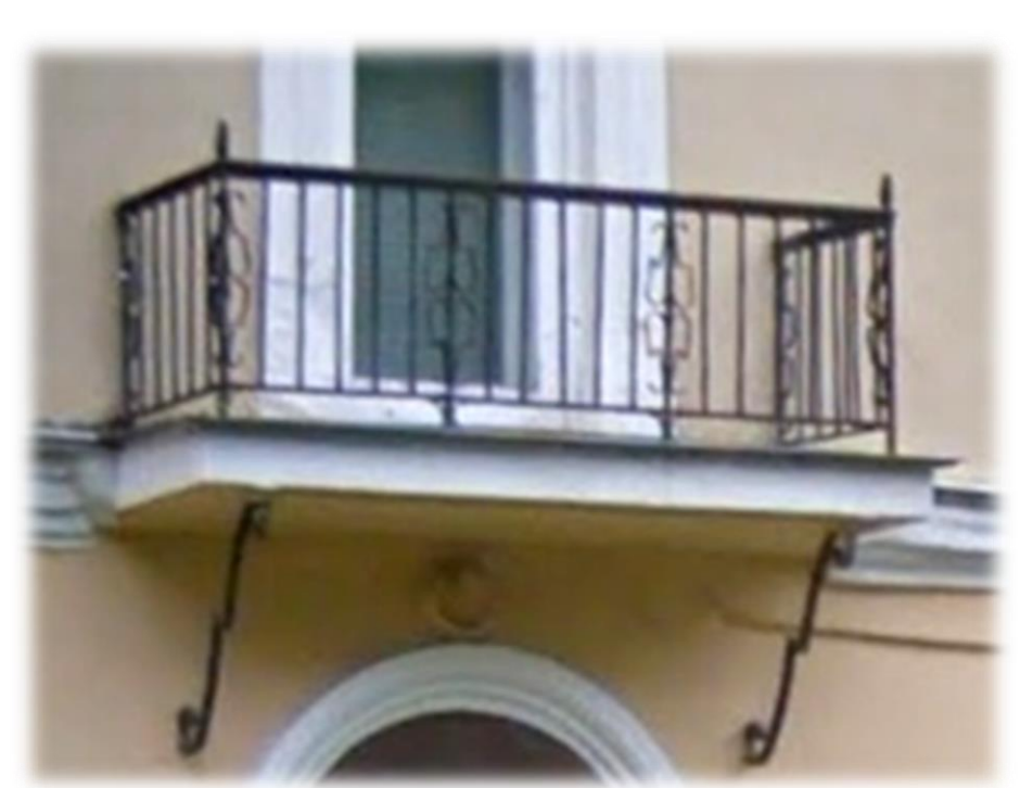
Тип 11. Балкон. Металлическое, кованое ограждение.
