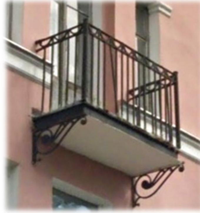
Тип 10-2. Балкон. Металлическое, кованое ограждение.
