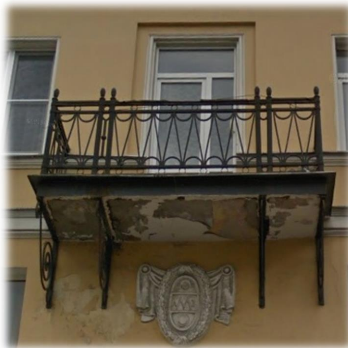
Тип 3. Балкон. Металлическое, кованое ограждение.
