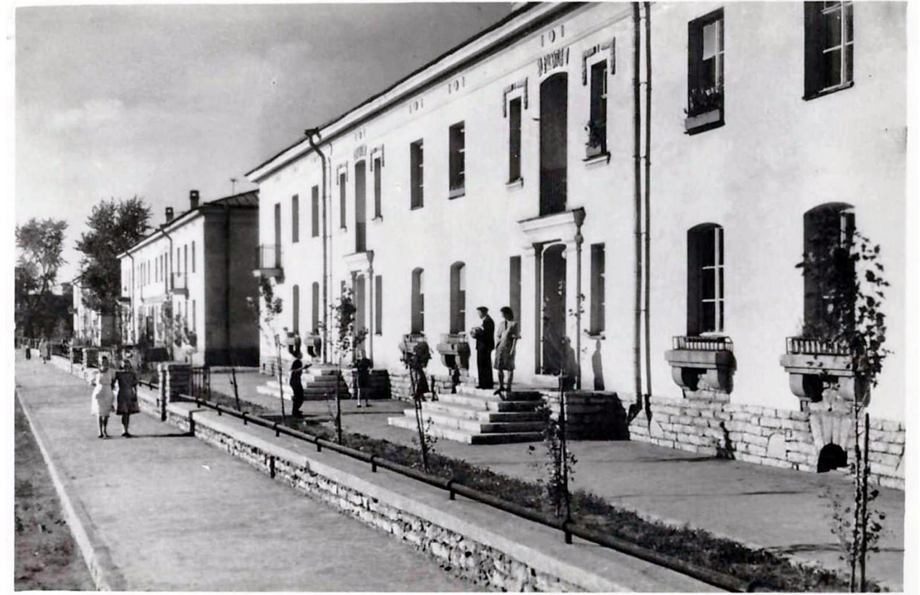
Застройка комплекса по улице Седова. Общий вид
