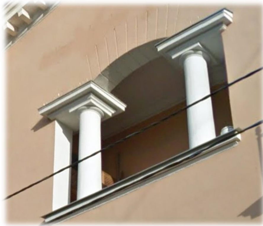
Тип 11. Образец оформления лоджии с использованием колонн тосканского ордера и клинчатой перемычки
