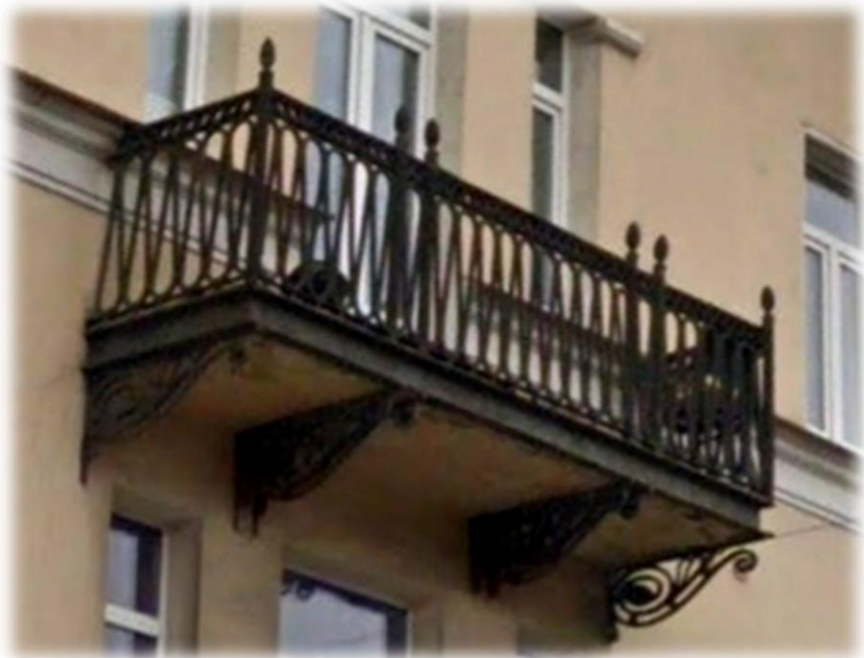
Тип 4. Главный фасад. Балкон. Металлическое, кованое ограждение.
