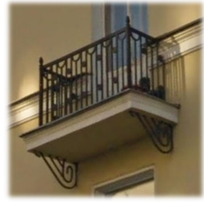
Тип 23. Балкон. Металлическое, кованое ограждение.
