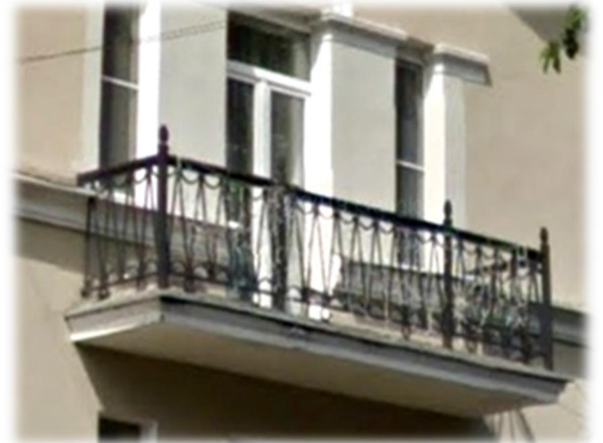
Тип 5-2. Балкон. Металлическое, кованое ограждение.
