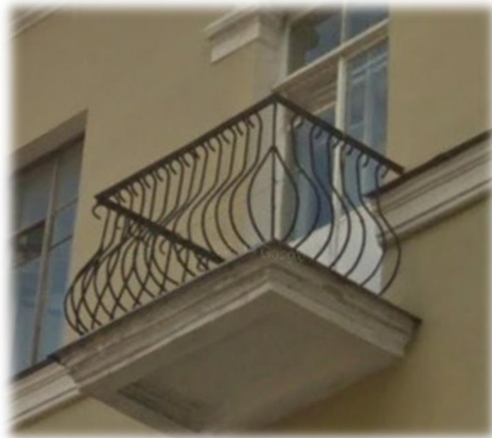
Тип 5-1. Балкон. Металлическое, кованое ограждение.
