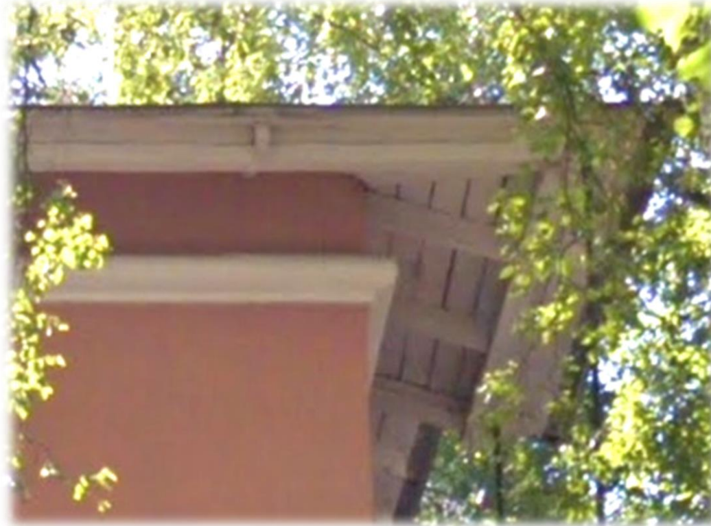
Тип 1. Карниз на кронштейнах
