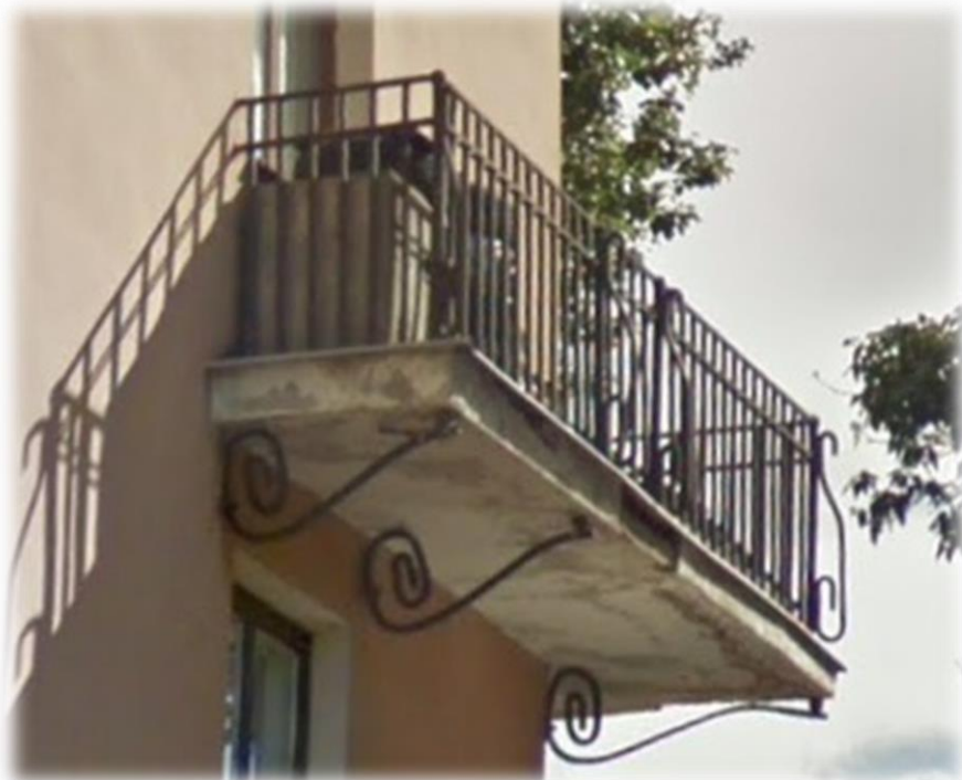
Тип 22. Балкон. Металлическое, кованое ограждение.
