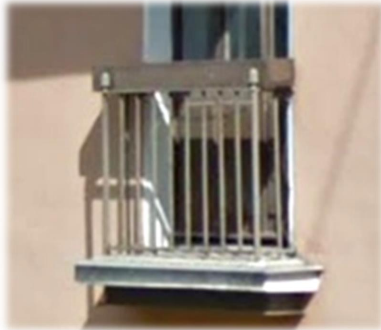
Тип 13. Балкон. Металлическое, кованое ограждение. Использован проект жилого дома в Волковской деревне.
