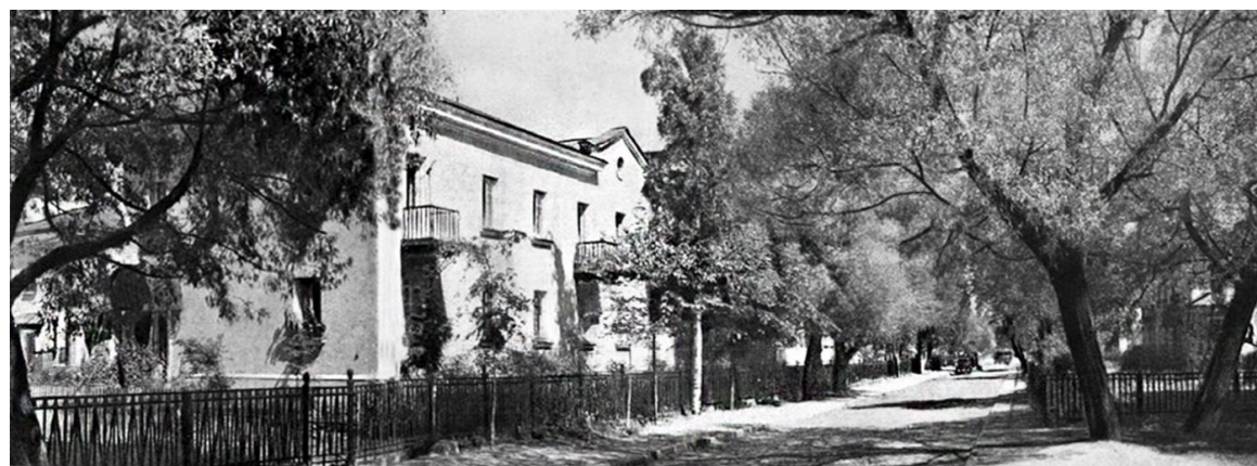
Внутриквартальная застройка. Общий вид
