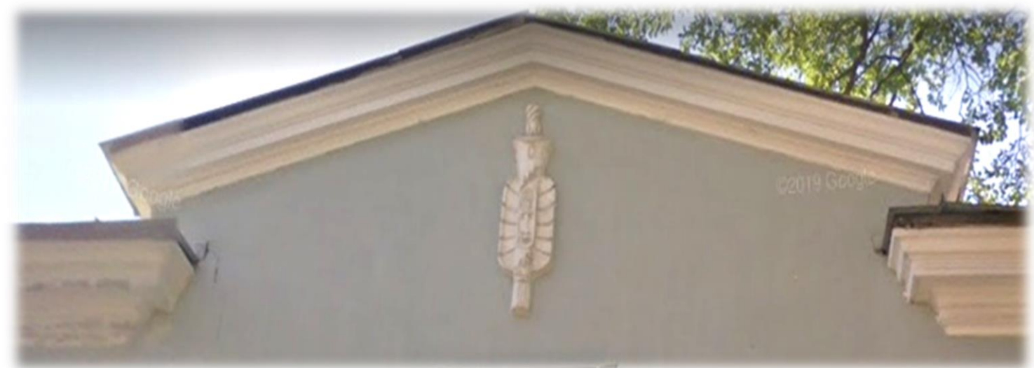
Тип 5. Полуфронтон с лепным, декоративным рельефом в тимпане. Лепной рельеф использован по образцу рельефа в комплексе за Пролетарским заводом (выполнено по рисункам Е.А. Левинсона)
