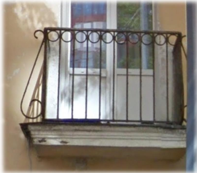
Тип 1. Балкон. Металлическое, кованое ограждение.
