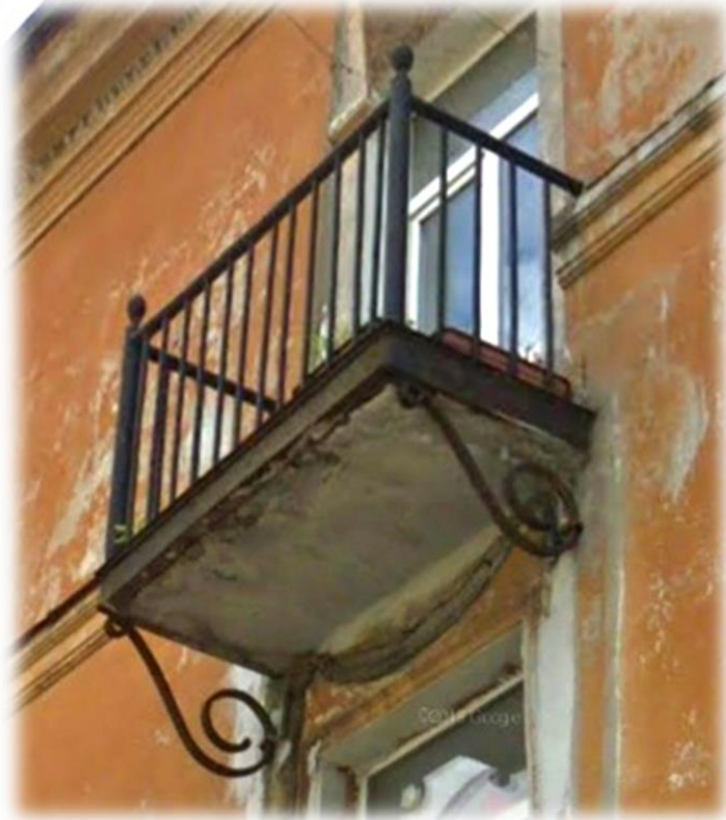
Тип 14. Балкон. Металлическое, кованое ограждение.
