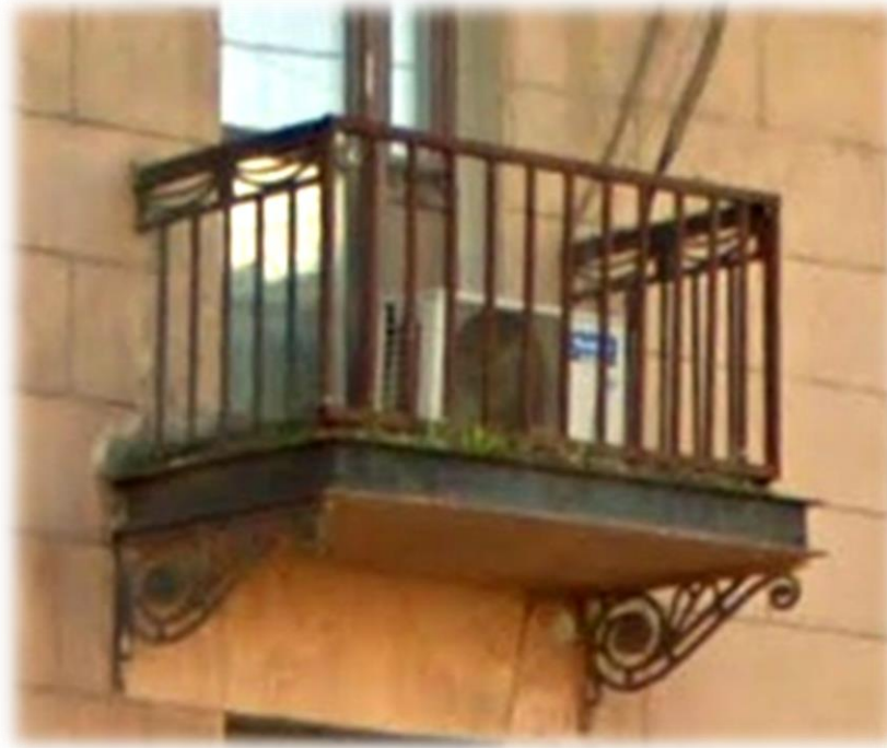
Тип 19. Балкон. Металлическое, кованое ограждение.
