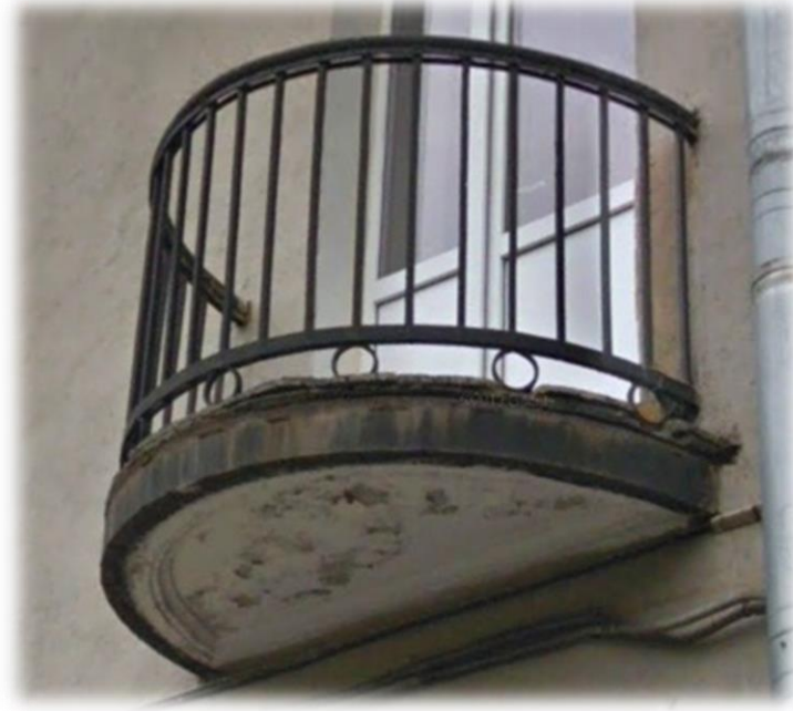
Тип 7. Балкон. Металлическое, кованое ограждение.
