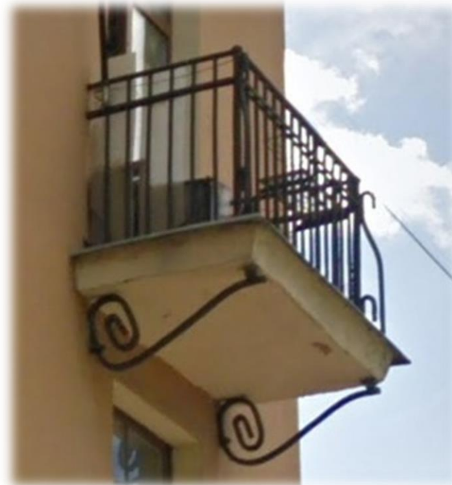
Тип 22. Балкон. Металлическое, кованое ограждение.
