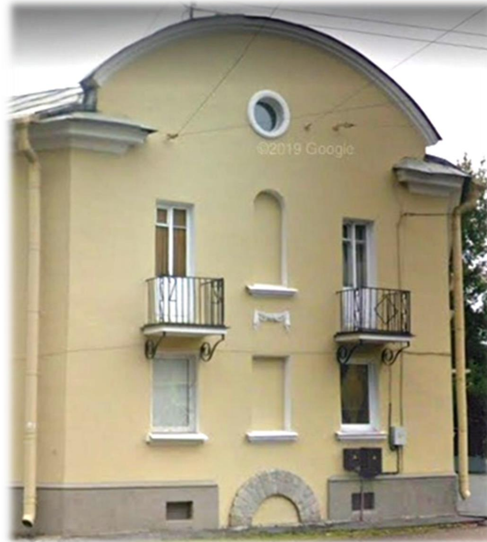
Тип 12. Образец оформления подоконного карниза, с металлической, кованой конструкцией для устройства цветов в кадках.
