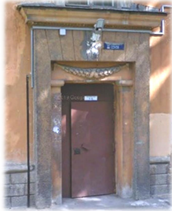
Тип 14. Входной портал. В составе оформления портала использованы пилястры, сандрик, лепная гирлянда и дверь с контрналичником. Дверное заполнение сохранилось.
