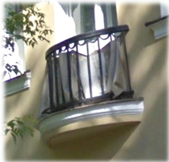
Тип 10. Балкон. Металлическое, кованое ограждение.
