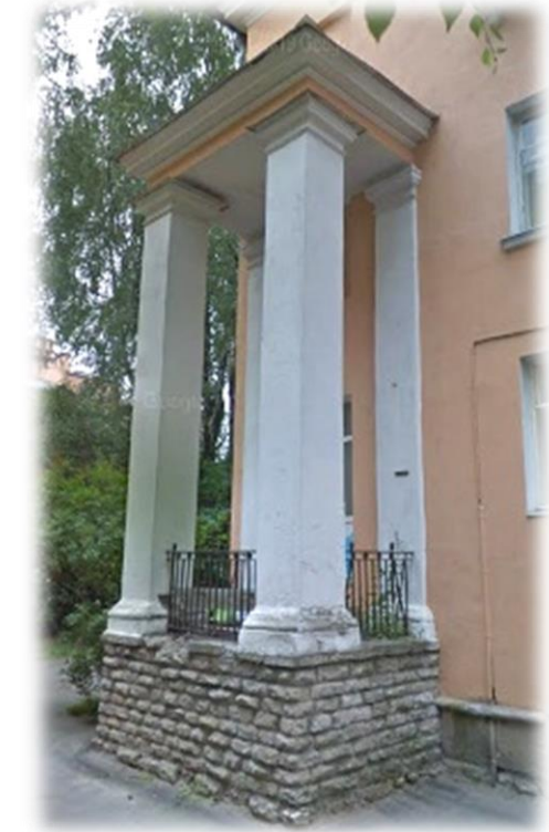
Тип 17 и 19. Образец оформления балкона в уровне первого этажа с колоннами и пилястрами в уровне первого и второго этажей и навесом (в уровне третьего этажа). Цокольная часть оформлена в каменной кладке (песчаник).
