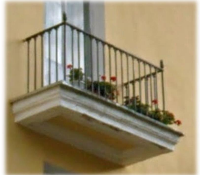
Тип 7. Балкон. Металлическое, кованое ограждение.
