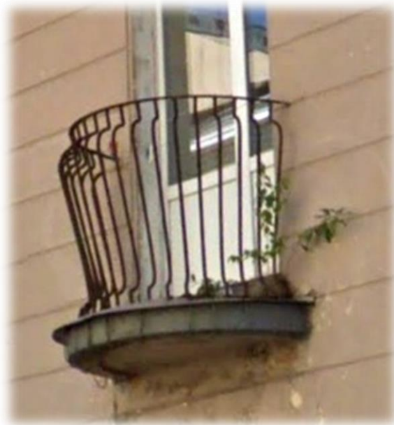
Тип 12. Балкон. Металлическое, кованое ограждение.
