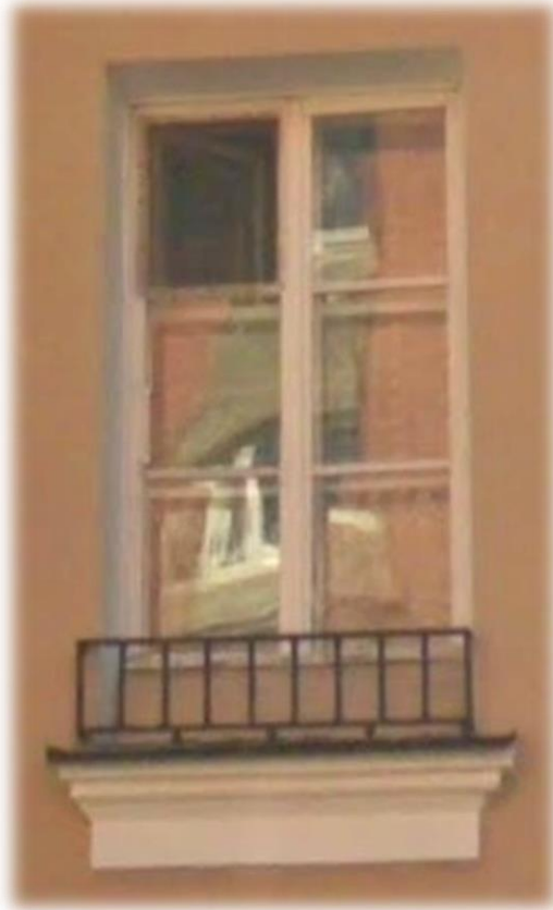
Тип 2. Образец оформления подоконного карниза, с металлической, кованой конструкцией для устройства цветов в кадках.
