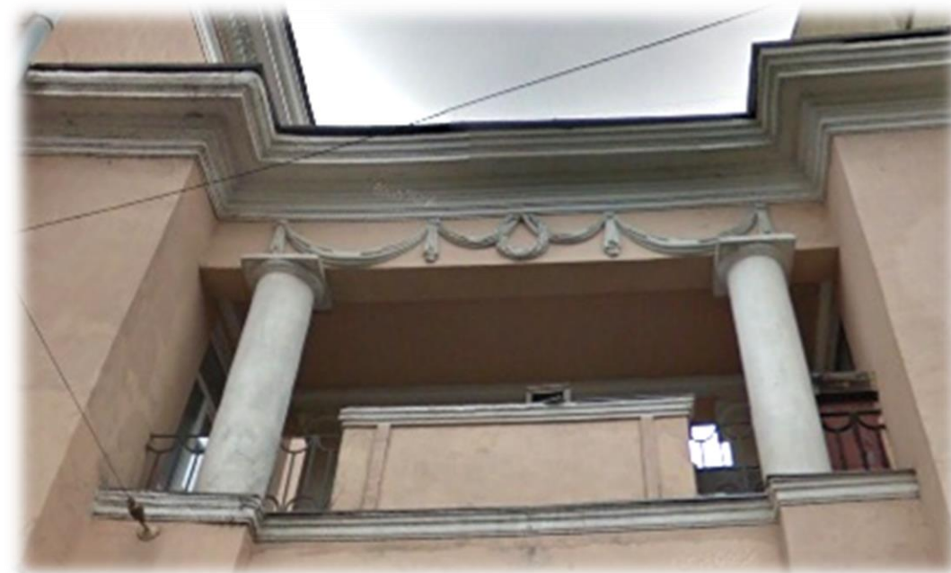
Тип 36. Образец оформления балкона с колоннами тосканского ордера и декоративной лепной композиции.
