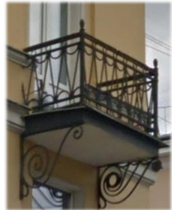
Тип 3. Балкон. Металлическое, кованое ограждение.
