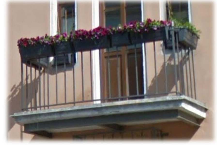
Тип 13 (Балкон. Металлическое, кованое ограждение. Использован проект жилого дома в Волковской деревне.
