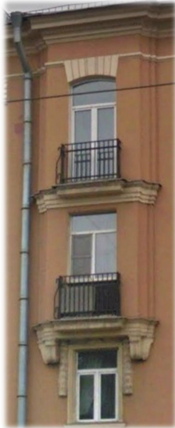
Тип 22. Эркер в уровне двух этажей. В составе оформления использован лепной декор, имитация клинчатой перемычки, кованые ограждения «французских» балконов.
