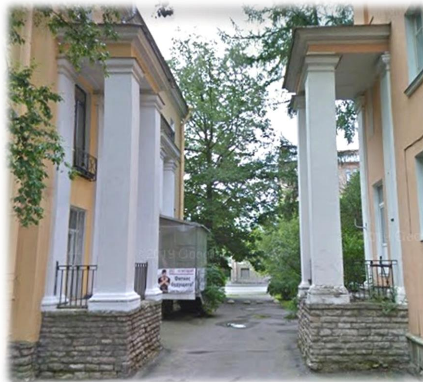
Тип 17 и 19. Образец оформления балкона в уровне первого этажа с колоннами и пилястрами в уровне первого и второго этажей и навесом (в уровне третьего этажа). Цокольная часть оформлена в каменной кладке (песчаник).
