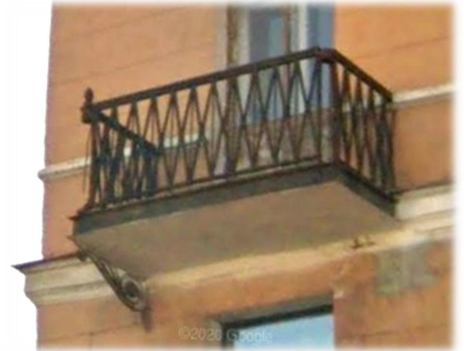
Тип 19. Балкон. Металлическое, кованое ограждение.
