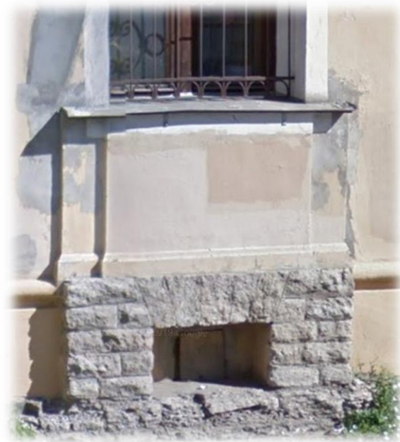
Тип 4. Подоконный парапет и цокольное окно, оформленное в каменной кладке с раскладкой на клинья
