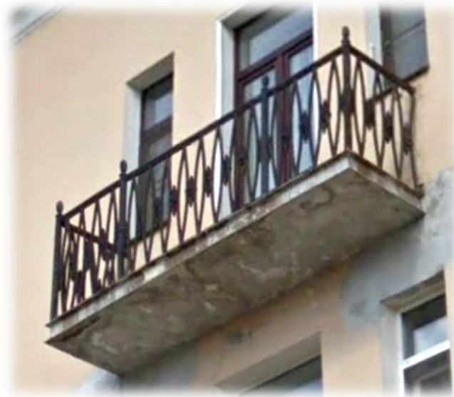
Тип 28. Балкон. Металлическое, кованое ограждение.
