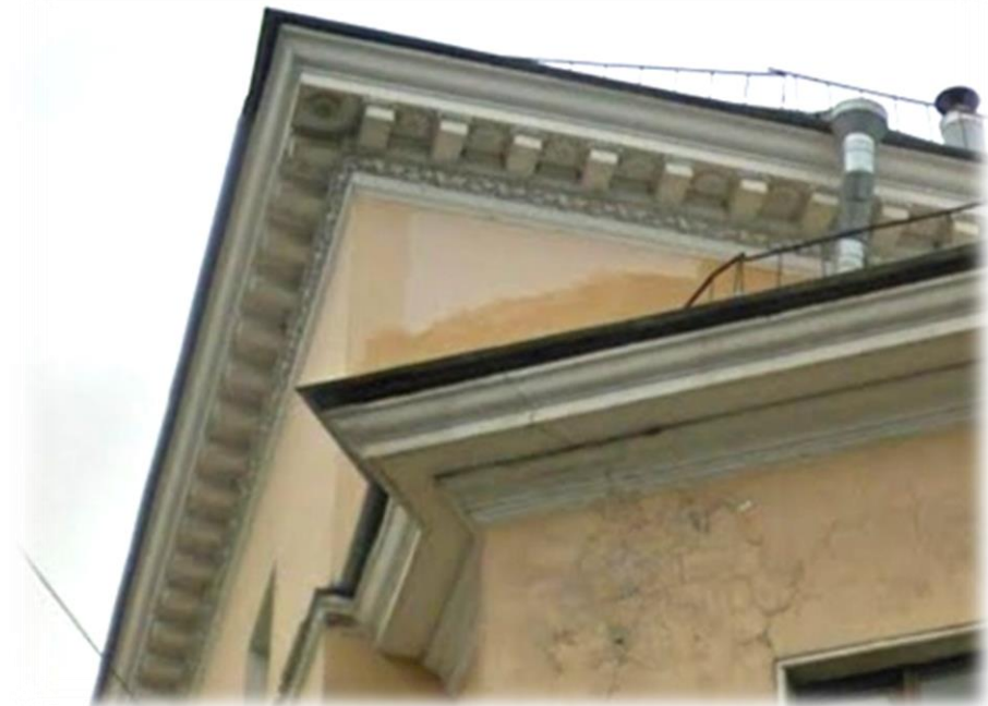
Тип 28. Профилированный, декорированный карниз с модульонами или кронштейнами.
