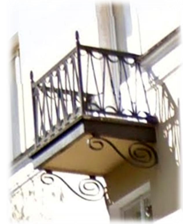
Тип 10. Балкон на декоративных кованых кронштейнах. Металлическое, кованое ограждение.
