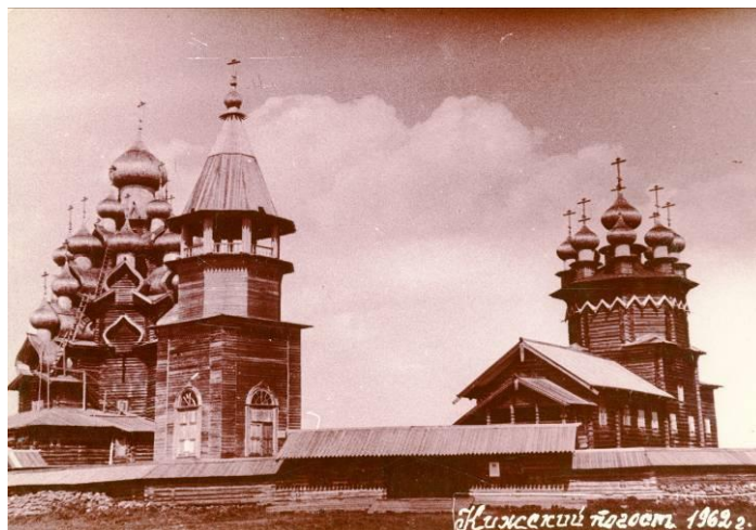
Кижский погост после реставрации 1954-1959 гг. Вид с юго-запада. Фото 1962 г.
