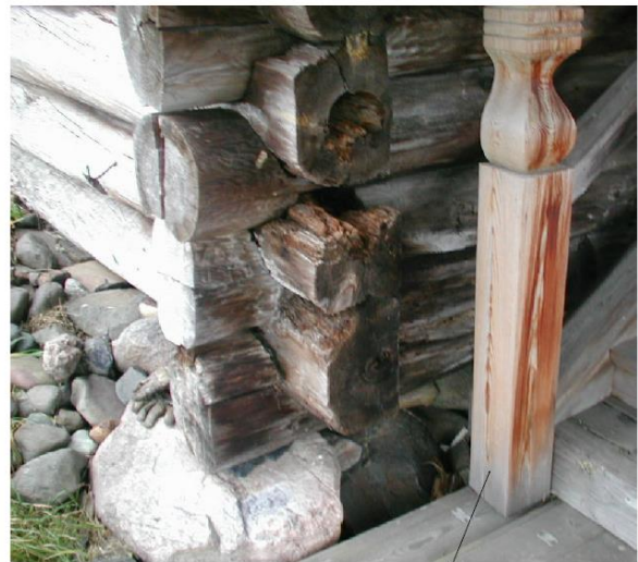
опорный столб кровли крыльца конца XIX в.
