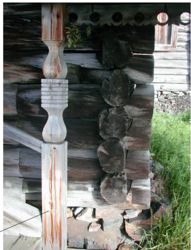
опорный столб кровли крыльца конца XIX в.
