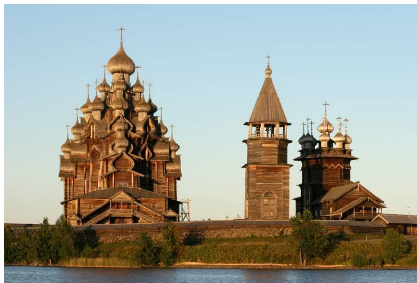
Кижский погост. Вид с запада. 2000 г.
