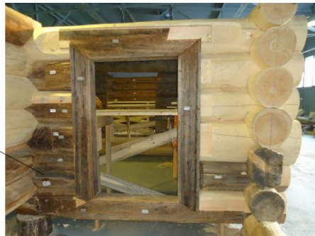
Фотофиксация в реставрационном комплексе 2013 г.
