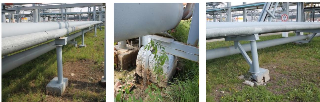
Рис. 1.3. Деформации фундаментов эстакады трубопроводов ООО «РН Комсомольский НПЗ».
