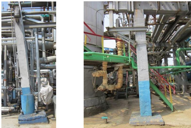
Рис. 1.4. Деформации фундаментов и стоек АО «ННК –Хабаровский НПЗ».
