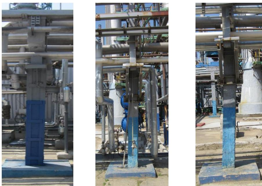
Рис. 4.1. Деформация надфундаментных конструкций стоек эстакады.
