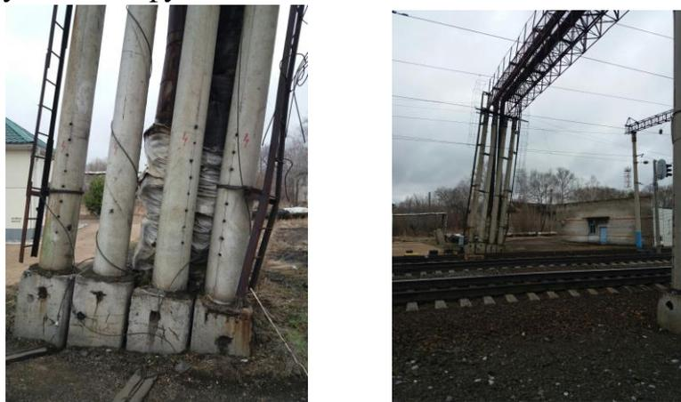
Рис.1.2. Деформация стоек эстакады топливных трубопроводов.
