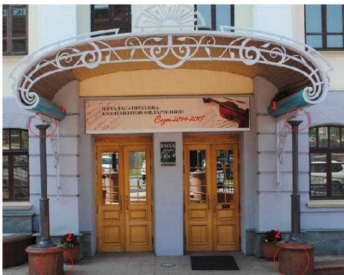
Рис.1.18. Деформации конструкций крыльца здания Хабаровской краевой филармонии в 2014 г., сопровождающейся просадкой фундамента и суффозией подстилающих грунтов. 1 - просадка конструкций колонн, 2 – растрескивание декоративных элементов баз колонн.
