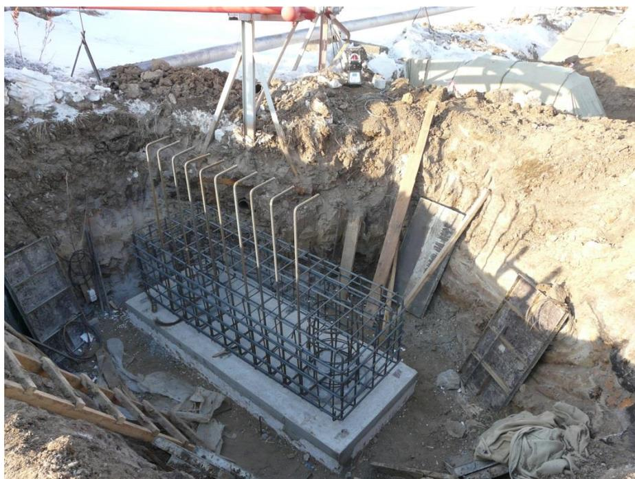
Рис. 1.12. Устройство теплоизоляции под отдельно стоящий фундамент на Самарском НПЗ.
