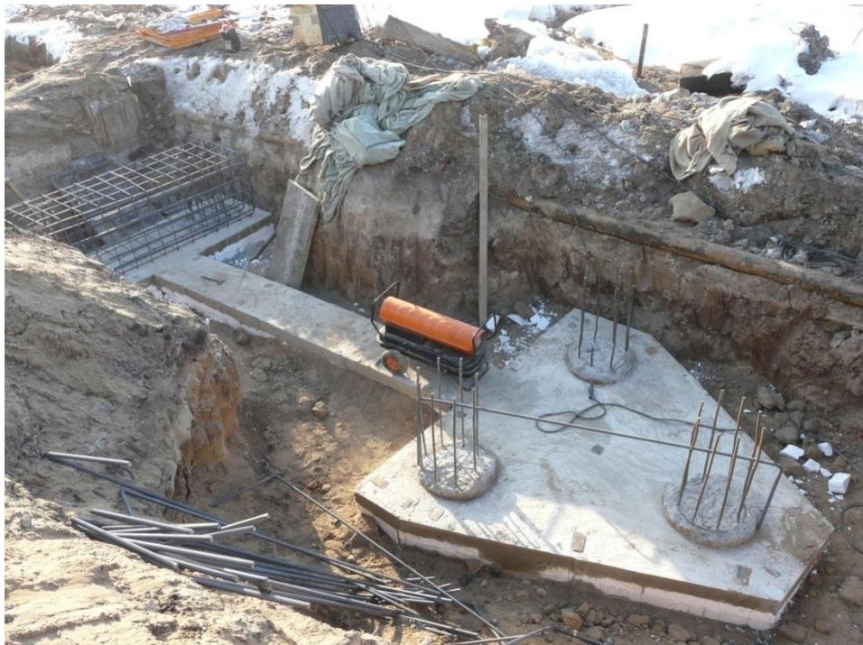
Рис. 1.11. Устройство теплоизоляции под фундамент оборудования на Самарском НПЗ.
