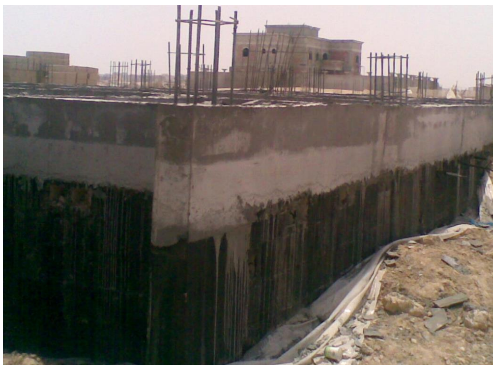
Рис. 5.3. Технологический этап строительства, использующий полиэтилен как барьер к проникновению засоленных вод.
