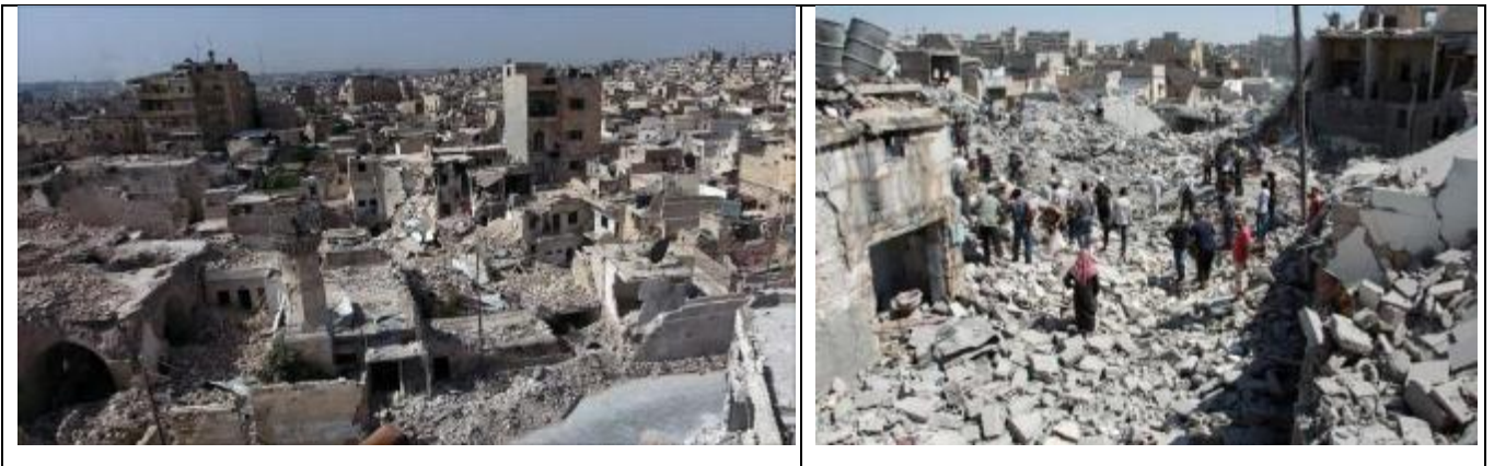
Рисунок В.3.1.2. Разрушенные районы в Алеппо.
