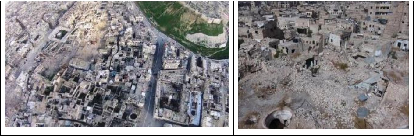
Рисунок В.3.1.1. Разрушенные районы в Алеппо.
