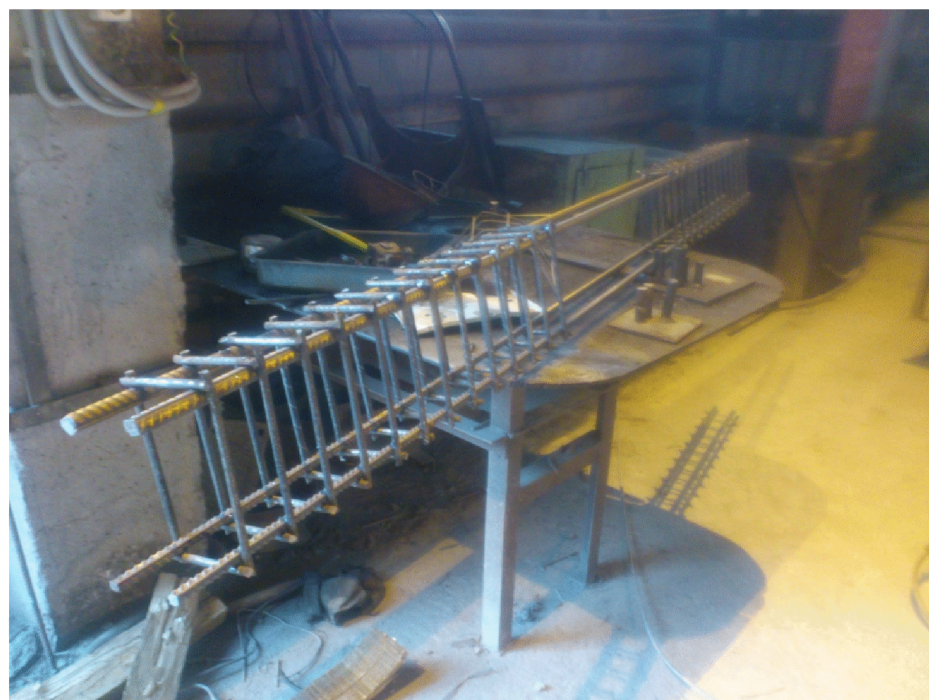
рис.3.2.1.2 Общий вид арматурных каркасов перед формованием
