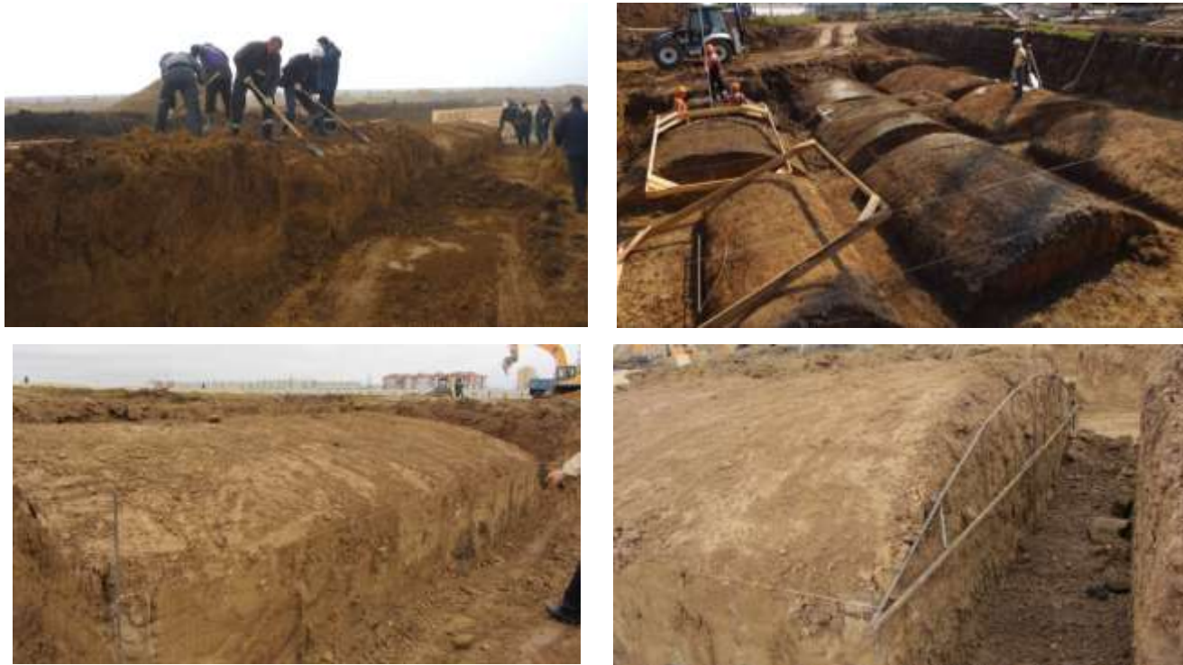
Рисунок 1.18. Ручная планировка основания с криволинейной цилиндрической поверхностью в пролетной части фундамента
