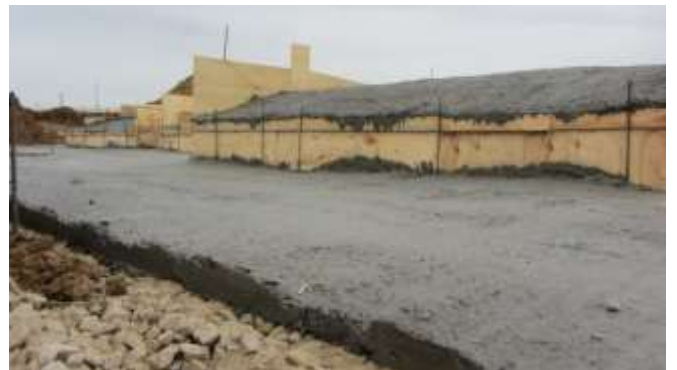
Рисунок 1.21. Подготовка тощим бетоном
