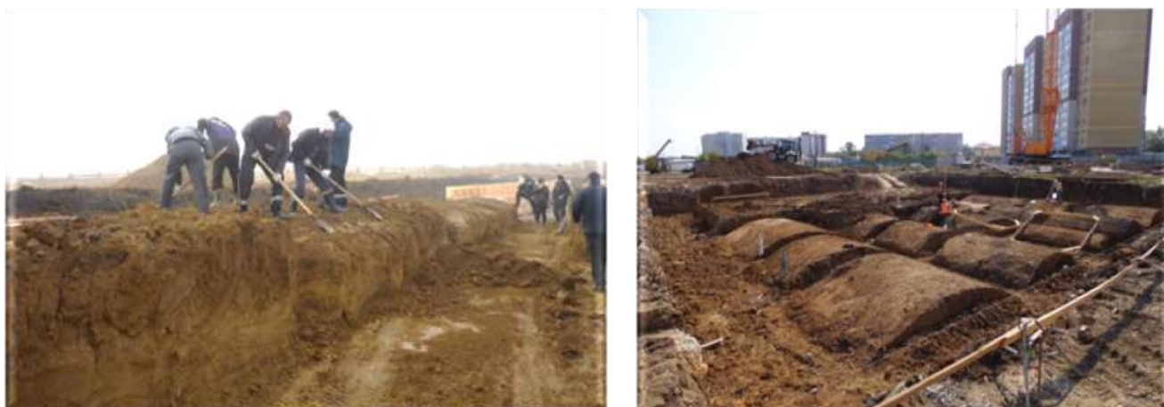
Рисунок 3.1. Ручное формирование профиля грунтового основания
