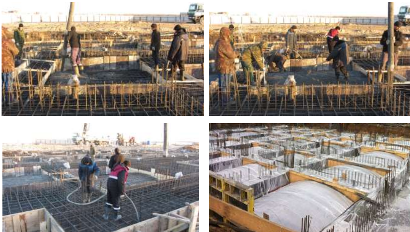
Рисунок 1.23. Бетонирование ленточной и оболочечной частей фундамента
