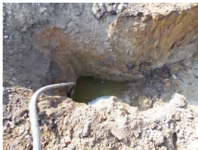
Рисунок 1.17. Разработка грунта в котловане с обустройством водоотвода
