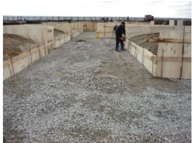
Рисунок 1.20. Устройство опалубочных конструкций
