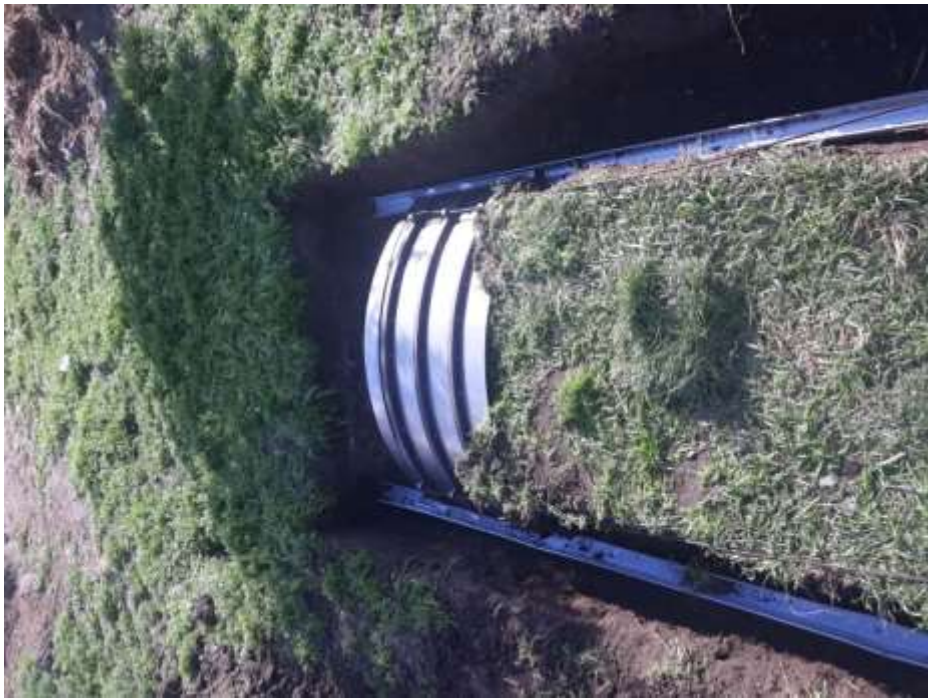
Рисунок 3.31. Первый этап. Срезка растительного слоя
