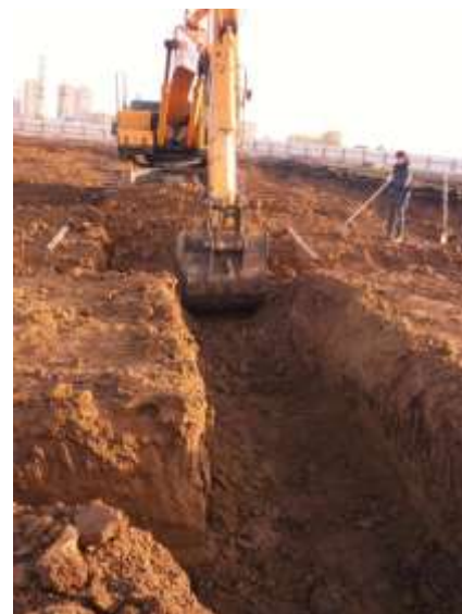
Рисунок 1.16. Технология выполнения земляных работ: а) разработка грунта в котловане; б) разработка грунта в траншеях под опорные контуры
