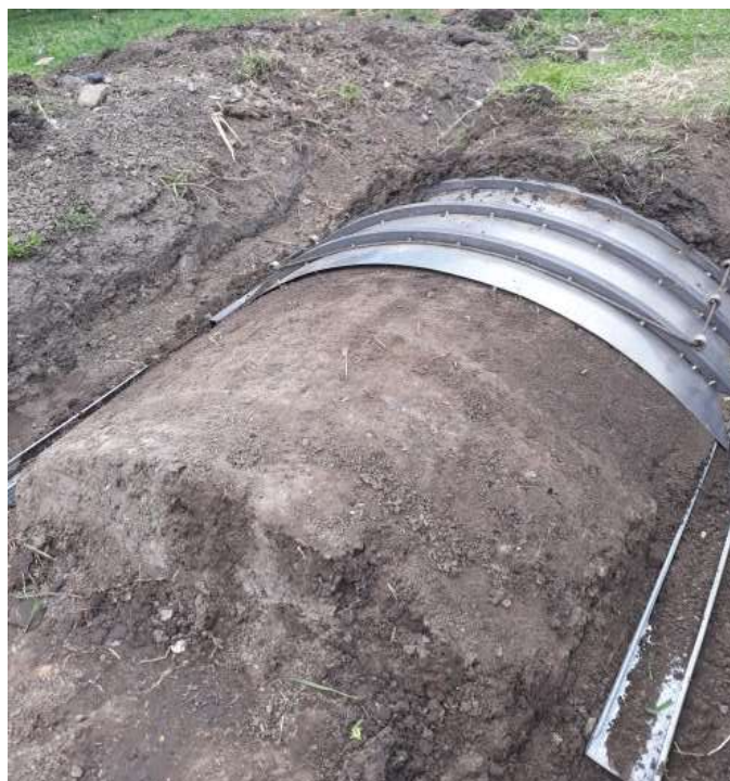
Рисунок 3.33. Формируемая поверхность грунтового целика
