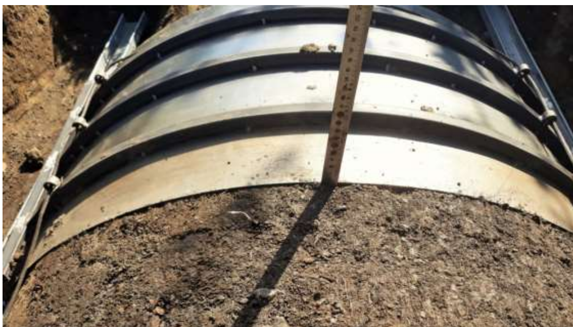
Рисунок 3.35. Фиксация отклонений геометрических параметров грунтового целика
