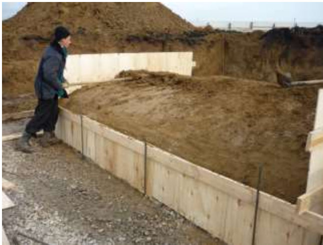
Рисунок 1.20. Устройство опалубочных конструкций
