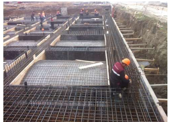
Рисунок 1.22. Армирование фундамента
