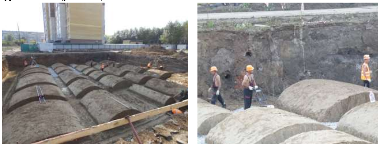
Рисунок 1.19. Щебеночная подготовка под ленточные части фундамента
