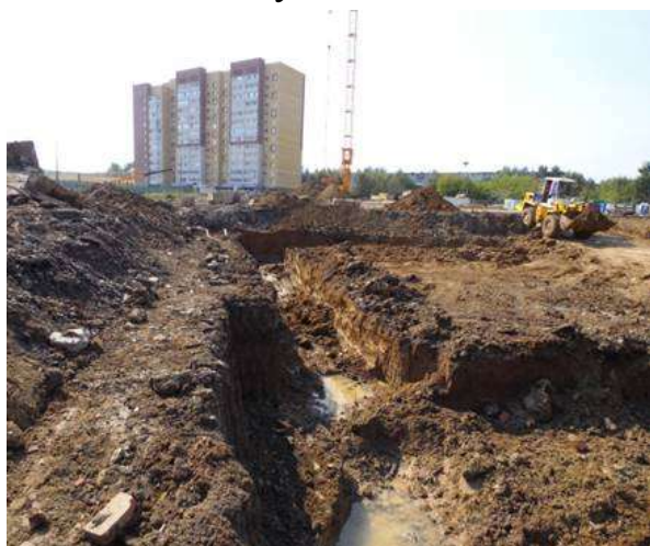
Рисунок 1.17. Разработка грунта в котловане с обустройством водоотвода
