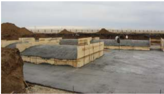
Рисунок 1.21. Подготовка тощим бетоном
