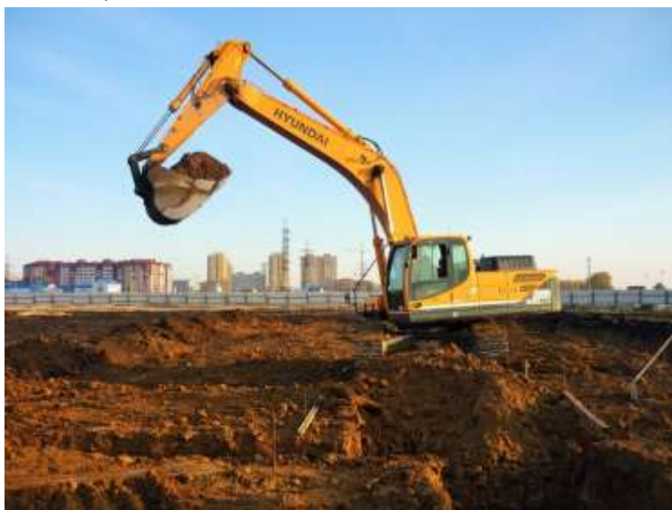
Рисунок 1.16. Технология выполнения земляных работ: а) разработка грунта в котловане; б) разработка грунта в траншеях под опорные контуры
