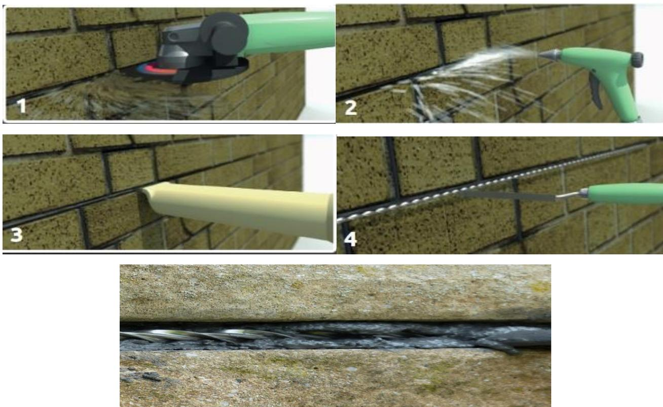
Рисунок 4.34 –Технология ремонта стен с трещинами называемая в Европе «Stitching Cracked Walls» предлагаемая компании «Thor Helical»:
