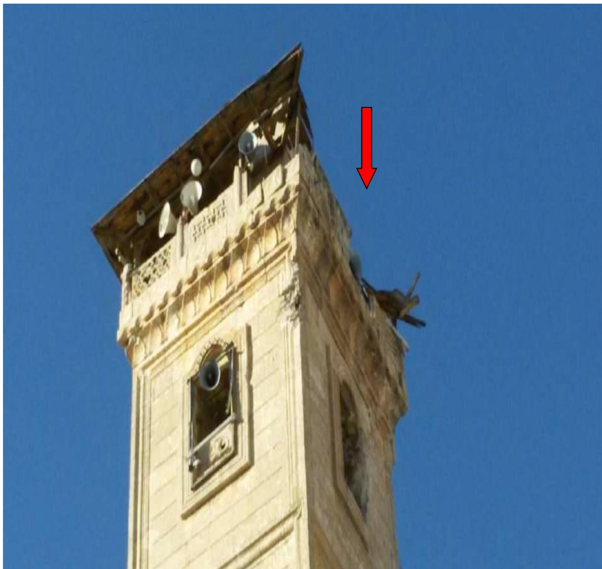
Рисунок 1.33 – Разрушения на Крыше минарета Большой мечети г. Маарат аль-Нуман в Сирии в результате войны.
