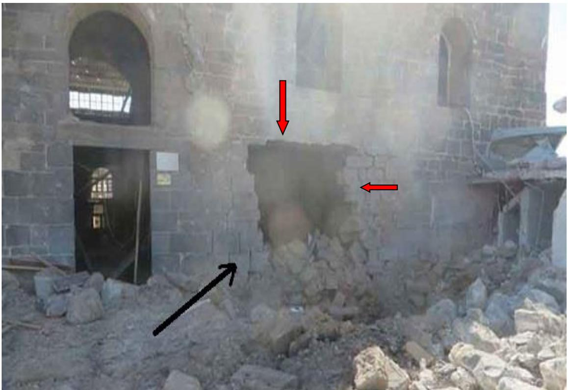
Рисунок 1.38 – Разрушения (пробойна) на фасаде мечети Омара в г.Босра в Сирии в результате войны.
