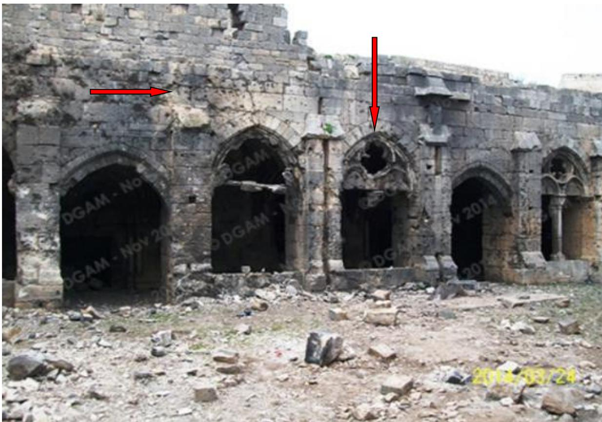
Рисунок 1.25 – Повреждения на фасаде рыцарского зала в замке Крак де шевалье в Сирии в результате войны.
