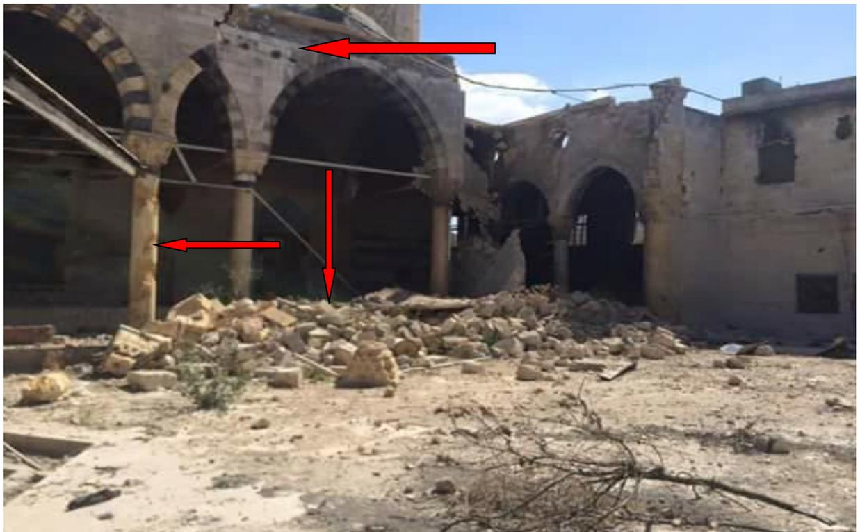
Рисунок 1.27– Разрушения и повреждения в арках и колоннах портика (галерей) и на стене мечети аль-Адилия в г. Алеппо в Сирии.
