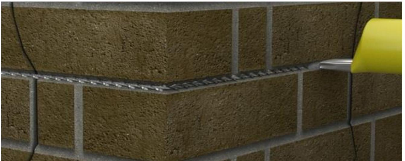
Рисунок 4.38 – Укрепление угловых стен при наличии трещин.
