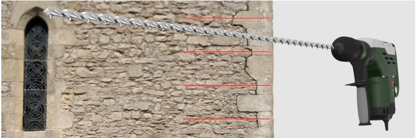
Рисунок 4.37 – Анкеровка угловых стен стержнями при наличии трещин.
