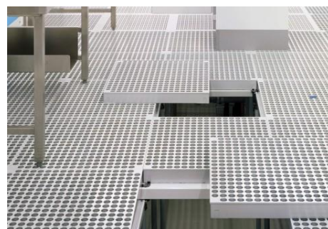
Рисунок 1.27 – Схема удаления воздуха через перфорированные панели в полу 1 – поток удаляемого воздуха; 2 – перфорированные панели; 3 – опоры фальшпола; 4 – воздушная камера
