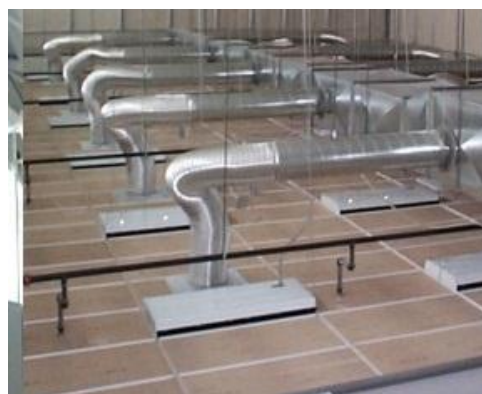
Рисунок 1.17 – Потолочные воздухораспределители
