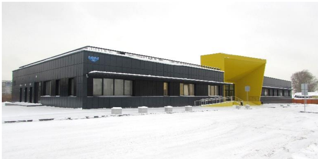
Рисунок 1.9 – Административное одноэтажное здание в Новосибирске (по материалам ООО «ИСП «Геореконструкция»)
