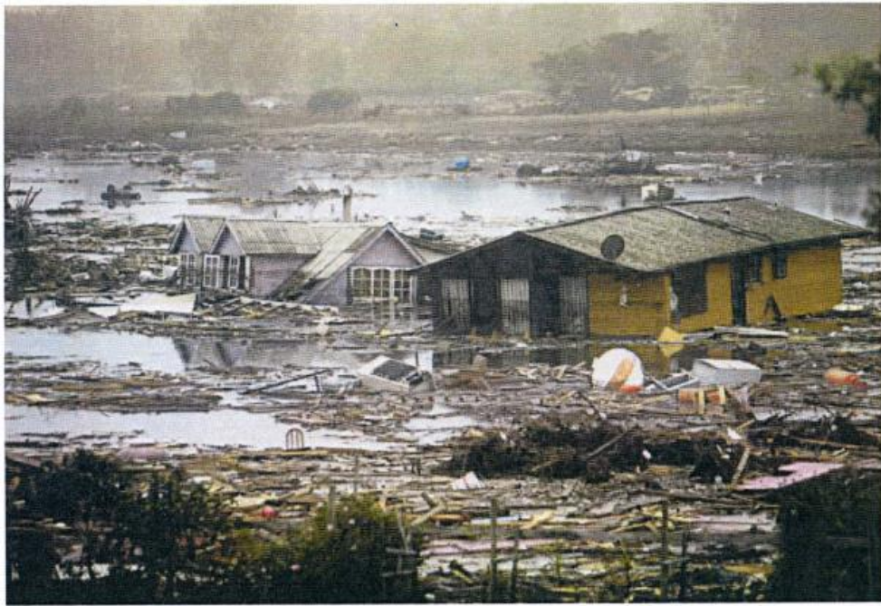
Рисунок 1.12 – Разрушенные волной цунами деревянные дома
