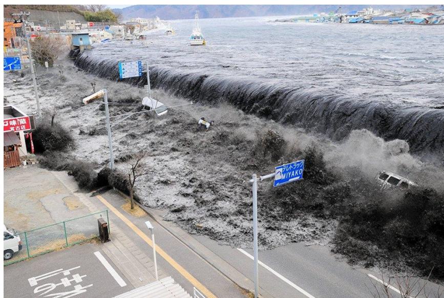
Рисунок 1.16 – Выход волны за берегозащитное сооружение
