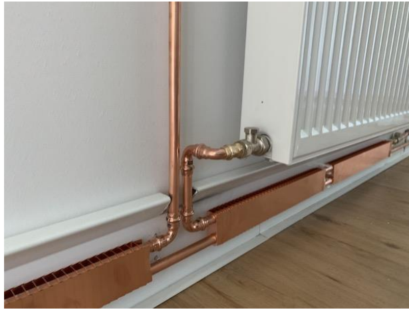
Рисунок 5.2 – Пример подключения дополнительного радиатора
