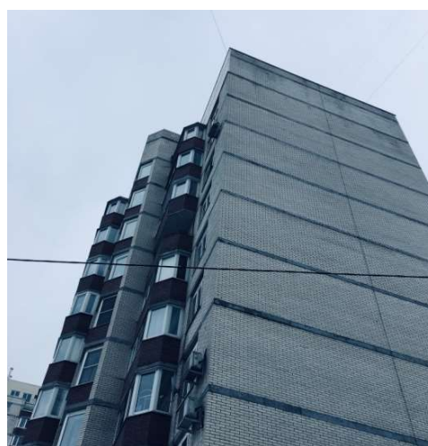
Рисунок 2.1 - Деструкция наружных стен теплых чердаков (эффективный и лицевой кирпич)
