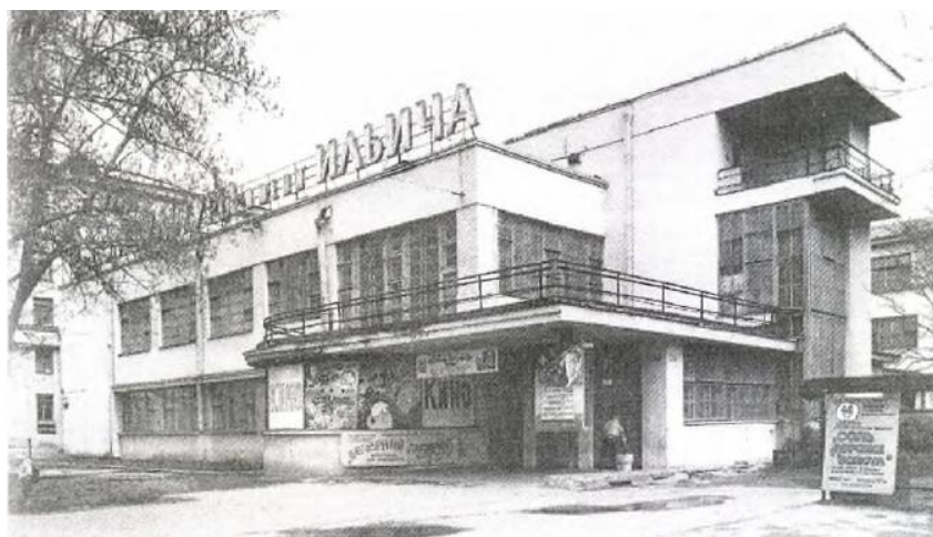
Рисунок Д.2.5. Арх. Н.Ф. Демков. Дом культуры им. Ильича. Общий вид. Фотография. 1992 г. Кириков Б. М., Штиглиц М. С. Архитектура ленинградского авангарда. Путеводитель. С-Пб.: Коло, 2008. С. 169.
