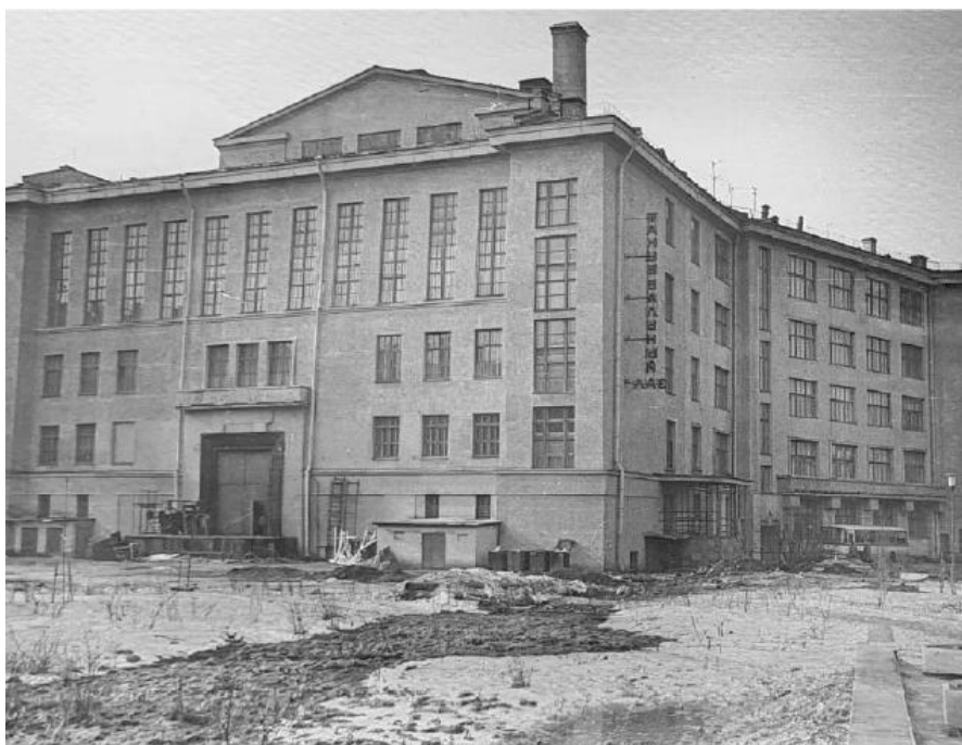
Рисунок В.2.17. Задний фасад здания с надстроенной частью. Акт по результатам государственной историко-культурной экспертизы проектной документации на проведение работ по сохранению объекта культурного наследия федерального значения «Дворец культуры им. Горького А. М.»/Трушковский В. Э., Полетайкин В. В., Глинская Н. Б.
