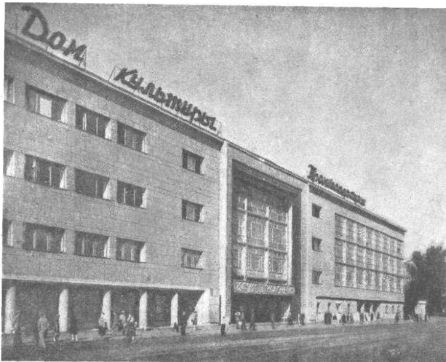
Дом культуры Промкооперации с залом на 2 100 мест в Ленинграде. 1932—1935 гг. Арх. Е. А. Левинсон и В. О. Мунц. Общий вид
