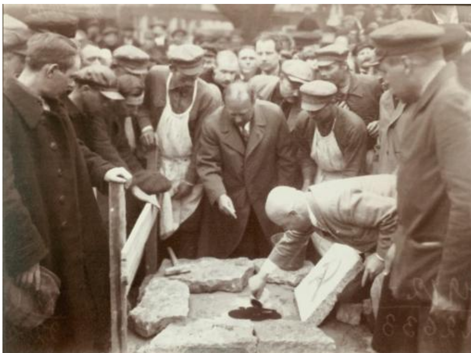
Рисунок Е.2.14. Укладка закладного камня в фундамент клуба. 1927 г. ЦГАКФФД СПб. Материалы с выставки «ДК в разрезе», подготовленной сотрудниками музея «Невская застава».
