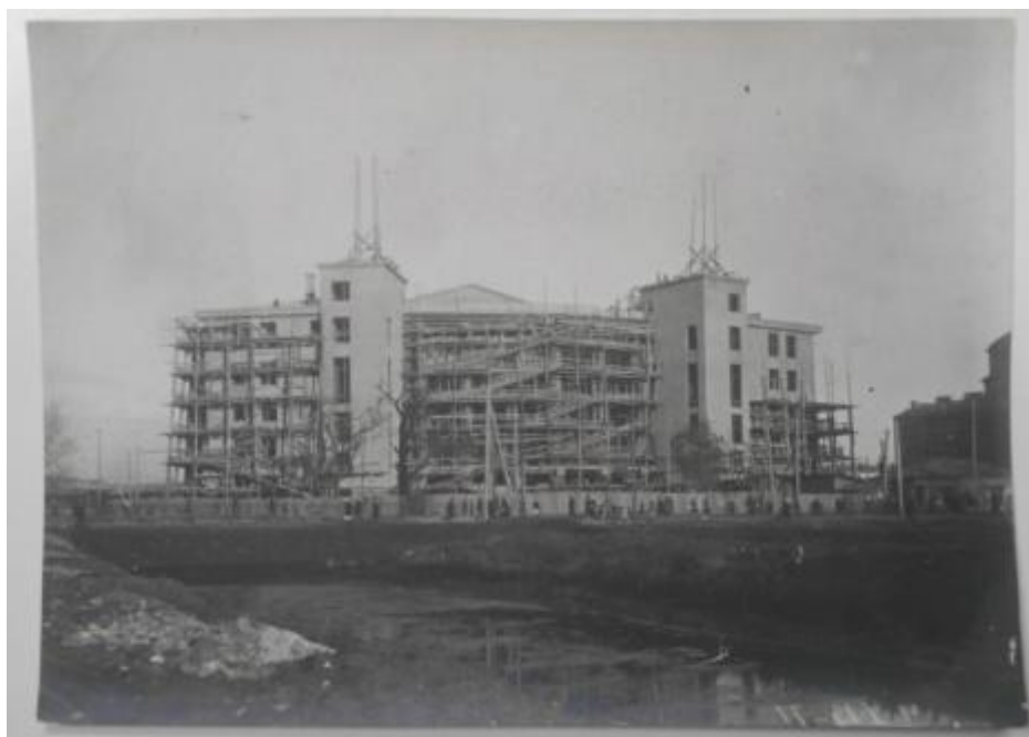
Рисунок В.2.18. Вид главного фасада здания в строительных лесах. Около 1927 г. ГНИМА им. А. В. Щусева ОФ-6339/1
