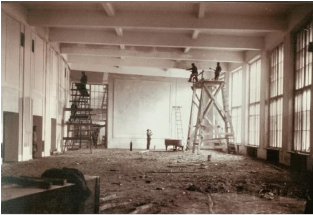
Рисунок Е.2.15. Строительство клуба фабрики «Рабочий». 1928 г. ЦГАКФФД СПб. Материалы с выставки «ДК в разрезе», подготовленной сотрудниками музея «Невская застава».
