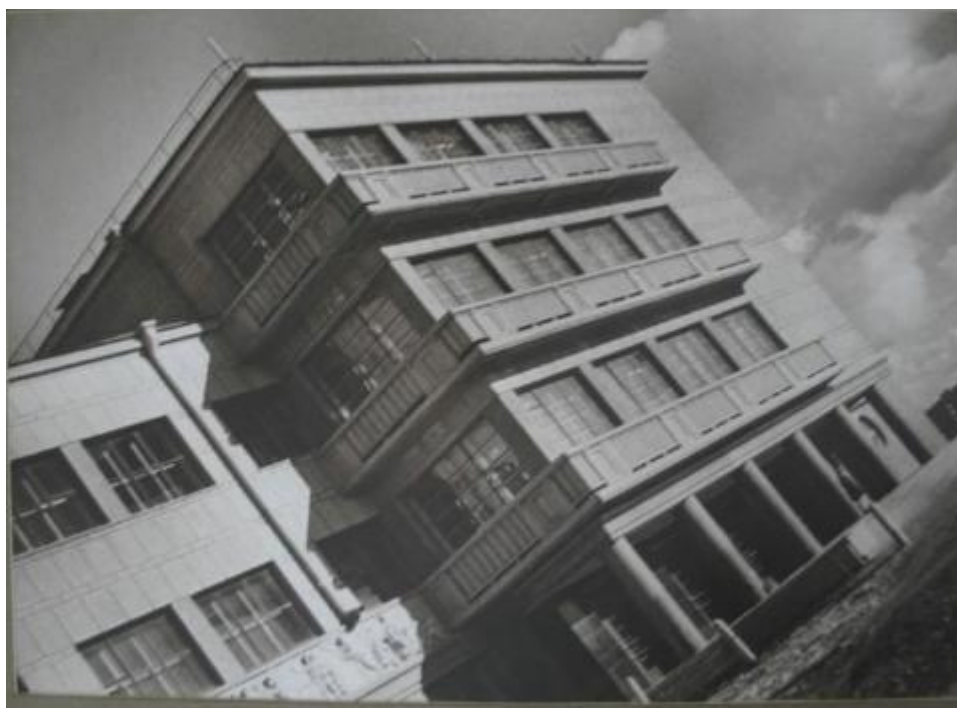
Рисунок Г.2.16. Дворец культуры им И. И. Газа. Кировского завода.Фрагмент фасада.1935 г.ГНИМА ОФ-1667/179 [Электронный ресурс]. URL: http://goskatalog.ru/portal/#/collections?id=15541582
