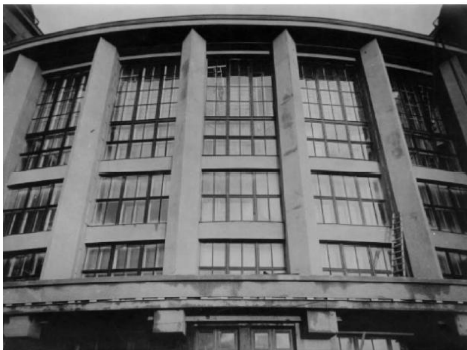
Рисунок В.2.3. Строительство Дома культуры в Московско-Нарвском районе. 1927 г. Акт по результатам государственной историко-культурной экспертизы проектной документации на проведение работ по сохранению объекта культурного наследия федерального значения «Дворец культуры им. Горького А. М.»/Трушковский В. Э., Полетайкин В. В., Глинская Н. Б.
