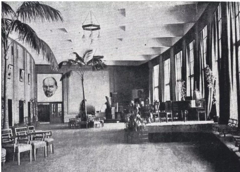
Рисунок Е.2.9. Фойе Володарского Дома культуры, 1933. Володарский район в социалистическом строительстве: [Альбом]. Л., [1934]. https://pastvu.com/p/206370
