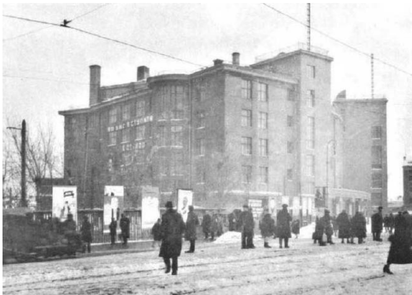
Рисунок В.2.5. Дом культуры в Московско-Нарвском районе. 1927 г. Акт по результатам государственной историко-культурной экспертизы проектной документации на проведение работ по сохранению объекта культурного наследия федерального значения «Дворец культуры им. Горького А. М.»/Трушковский В. Э., Полетайкин В. В., Глинская Н. Б.
