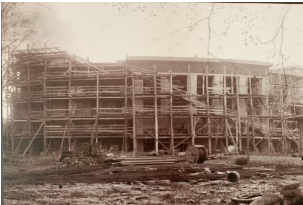
Рисунок Е.2.13. Строительство клуба фабрики «Рабочий». 1928 г. ЦГАКФФД СПб. Материалы с выставки «ДК в разрезе», подготовленной сотрудниками музея «Невская застава».
