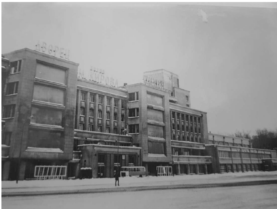
Рисунок А.2.4. Дворец культуры имени С.М. Кирова (Большой проспект Васильевского острова, д.83). Общий вид с юга. Фото 1930-х гг. Акт по результатам государственной историко-культурной экспертизы проектной документации на проведение работ по сохранению объекта культурного наследия Федерального значения №Дворец культуры им. Кирова С. М.» /Михайловская Г. В., Глинская Н. Б., Прокофьев М. Ф. СПб., 2018
