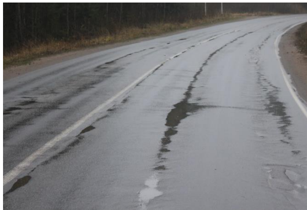
Рисунок 3.15 – Фиксация наличия пленки воды на поверхности покрытия
