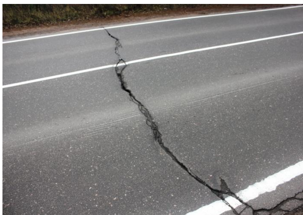
Рисунок 3.9 – Состояние экспериментального покрытия в разные периоды года: а) при t=0+30^{\circ}\text{C} ; б) при t=-10-0^{\circ}\text{C}
