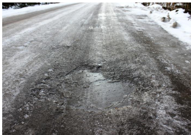
Рисунок 3.9 – Состояние экспериментального покрытия в разные периоды года: а) при t=0+30^{\circ}\text{C} ; б) при t=-10-0^{\circ}\text{C}
