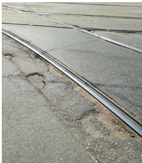
Рис. 3.30 Внешний вид участка трамвайного полотна
