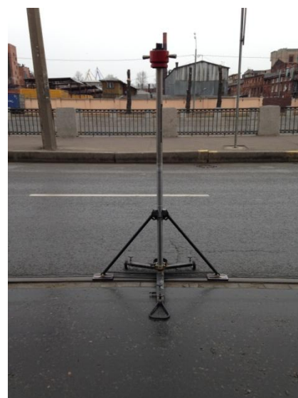
Рис. 3.7 Поверхность рельс трамвайных путей
