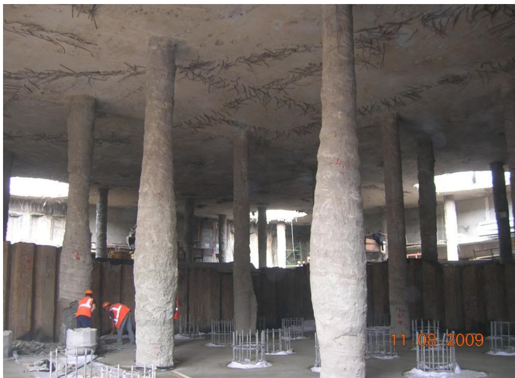
Рисунок 2.2.1. Местные уширения ствола сваи под давление бетонирования
