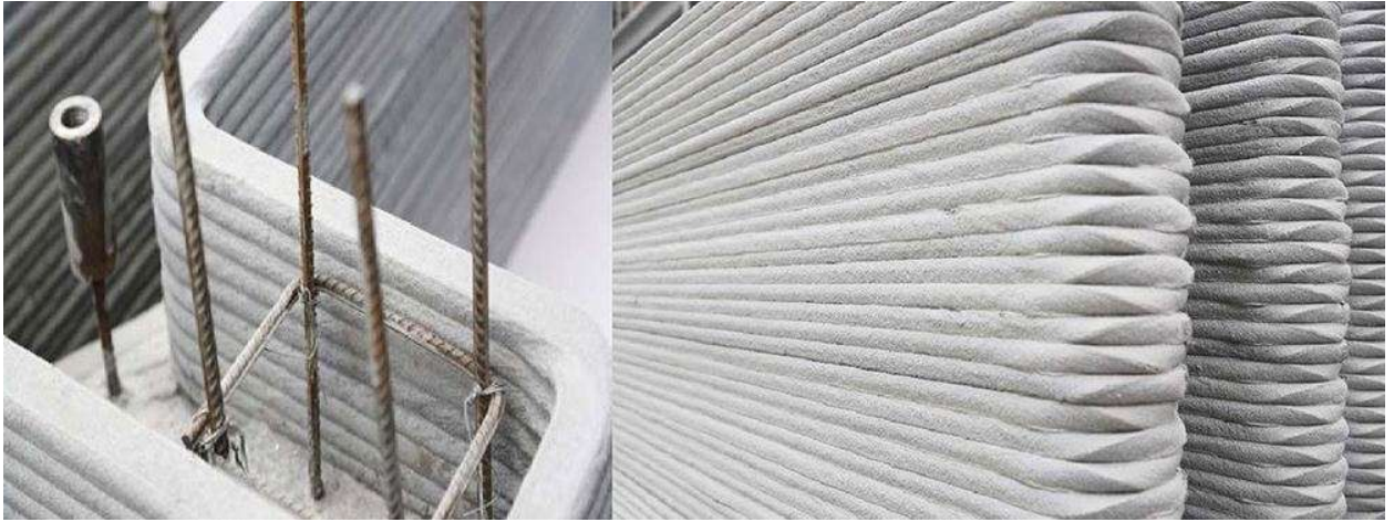
Рисунок 1.1 – Напечатанные на 3D-принтере строительные конструкции
