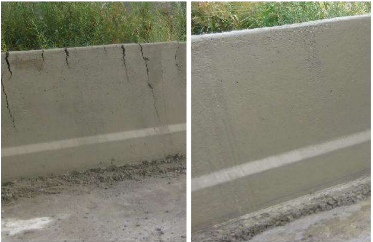
Рисунок 2.1 – свежесформованный дорожный отбойник по технологии непрерывного безопалубочного формования: а) с выраженными трещинами; б) без дефектов.
