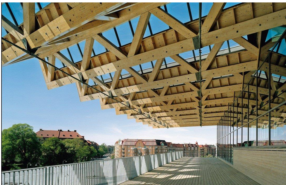
Рис. 1.4. Universeum Gothenburg, (Год постройки: 2001, Архитектор: Wingårdh Arkitektkontor AB, Gothenburg, Конструктор: FB инженер AB, пять этажей)
