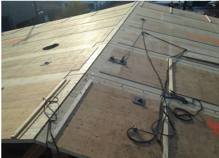
Рисунок 1.7. Монтаж деревоплит в покрытии.
