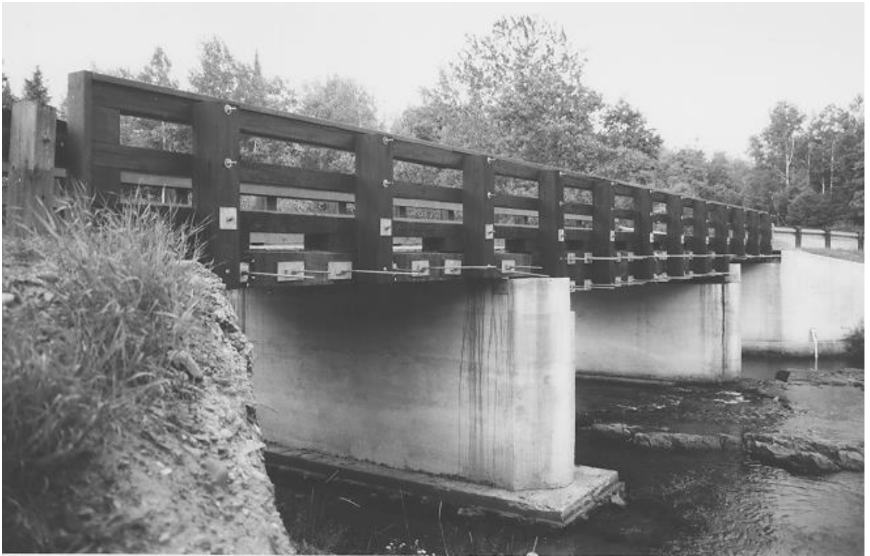
Рисунок 1.21. Общий вид моста с предварительно напряженной многослойной древесиной. Мост Большого Эрика на р. Гурон (Big Eric's Bridge, Huron river).
