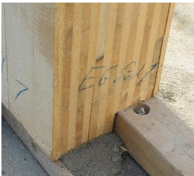
Рисунок 1.3. Опорный узел перекрестной дощато-гвоздевой стеновой панели.
