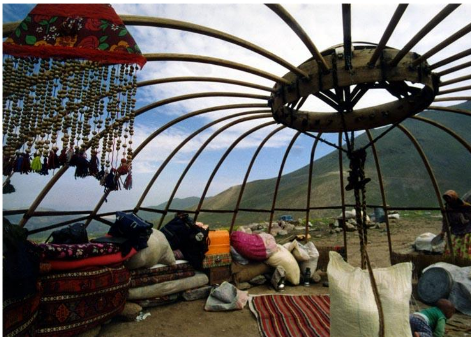
Рисунок 1.10. Алачыг, конструкция несущего каркаса.
