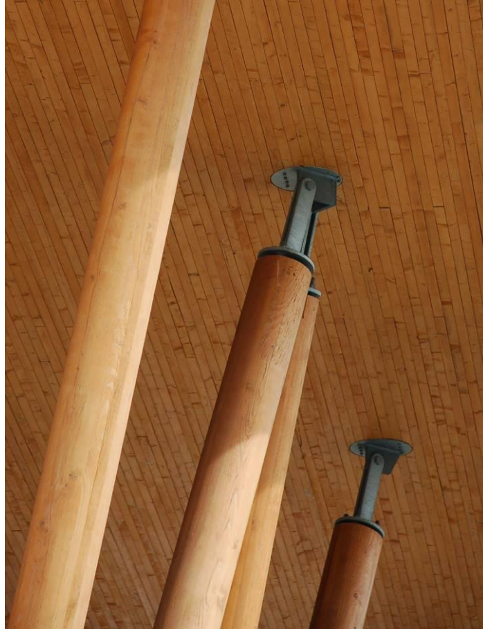
Рисунок 1.6. Безригельное опирание деревоплиты.
