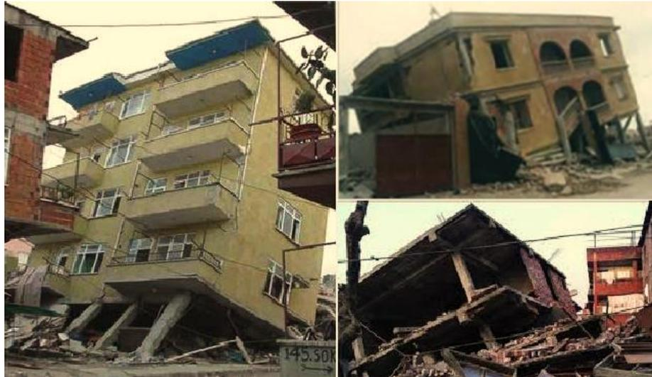
Рисунок 14. Разрушение ЖБКНИ зданий
