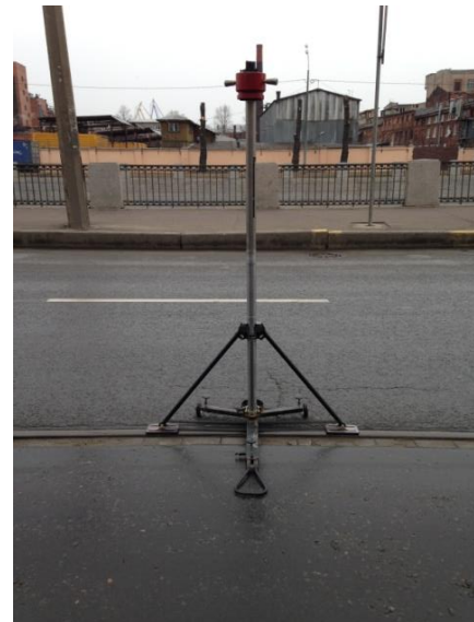
Рисунок 4.20 – Измерения на рельсе трамвайных путей
