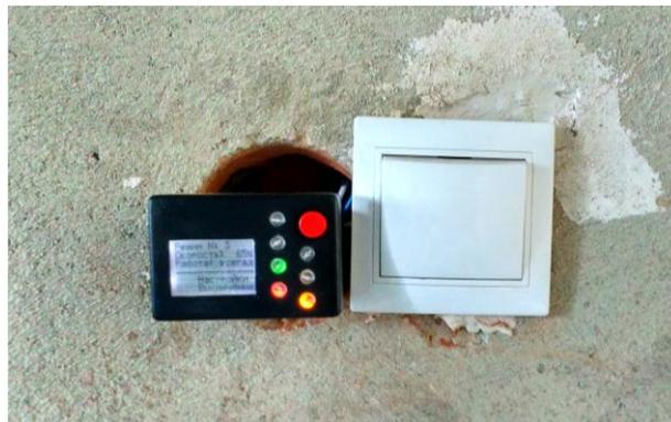
Рисунок 5.16 – Замеры перепада давлений с помощью дифференциального цифрового манометра ДМЦ-01А (а) и регулирование скорости вращения вентилятора с помощью блока управления вентилятором (б)
