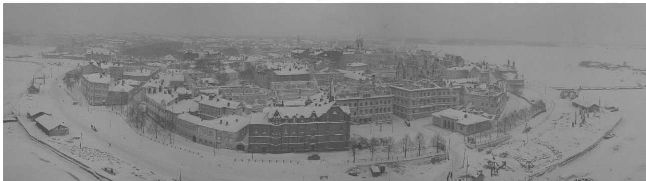
Рис. 1. Вид с башни Св. Олафа 1940-х гг. ( http://ristikivi.spb.ru/v_viipuri.html )
