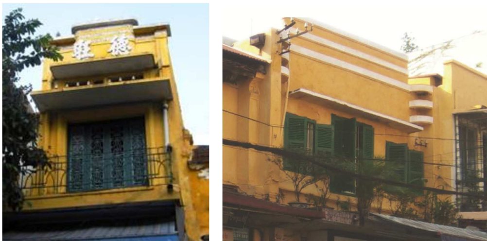
Рис. 3.67 «Трубчатые» дома с фасадом в манере ар-деко
