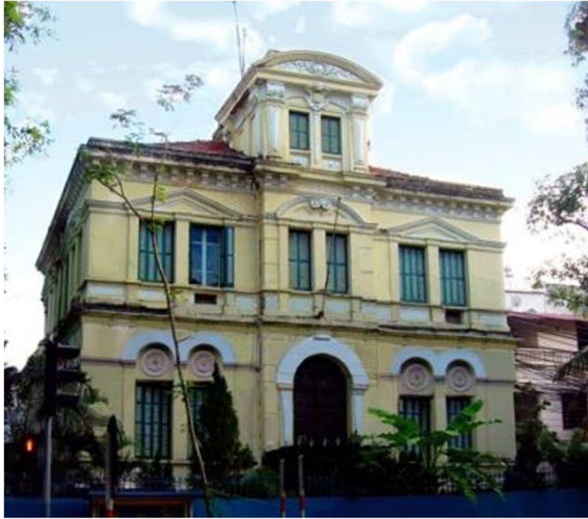
Рис. 3.43. Особняк в стиле «чистого» неоклассицизма на улице Чан-Хынг-Дао (№ 58)
