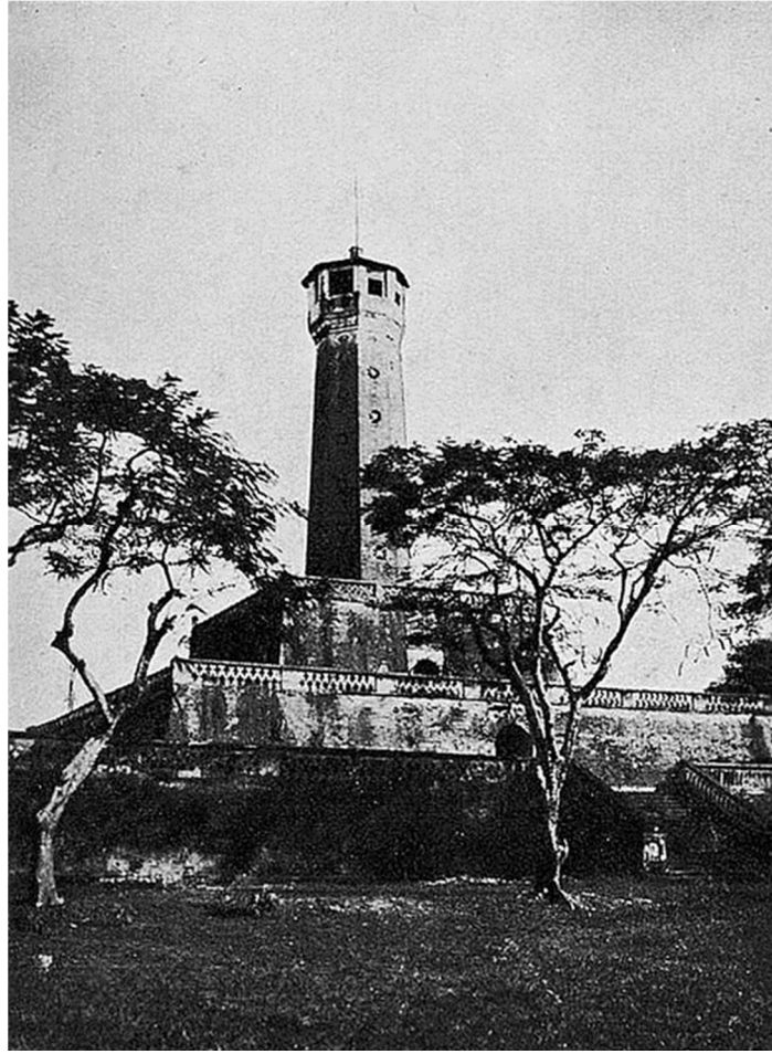
Рис. 3.6. Башня-флагшток. Фото 1912 г.
