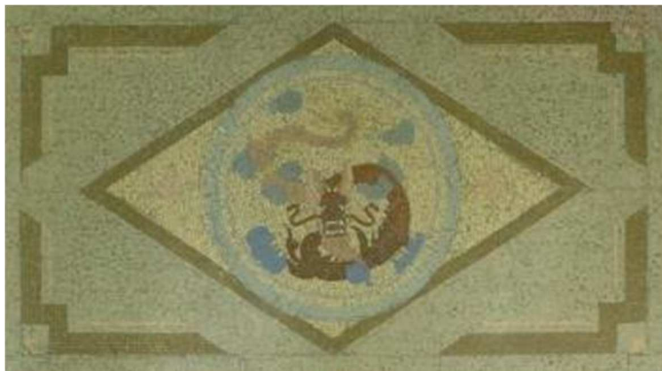
Рис. 3.54. а – Оконные проемы особняка на улице Тон-Дан; б – Мозаика на полу здания резидента Тонкина
