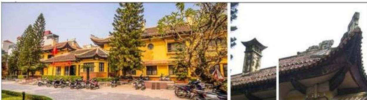
Рис. 3.68. Жилые дома: а – «трубчатый» дом; б – вилла для французских офицеров и вилла; в – клуб морской пехоты
