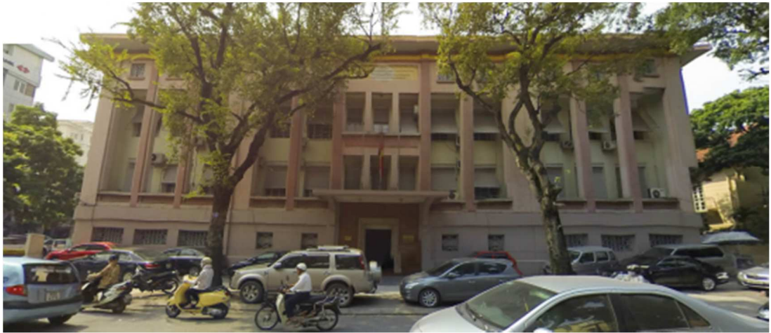
Рис. 3.58. Здание штаба-квартиры компании AVIAT.
