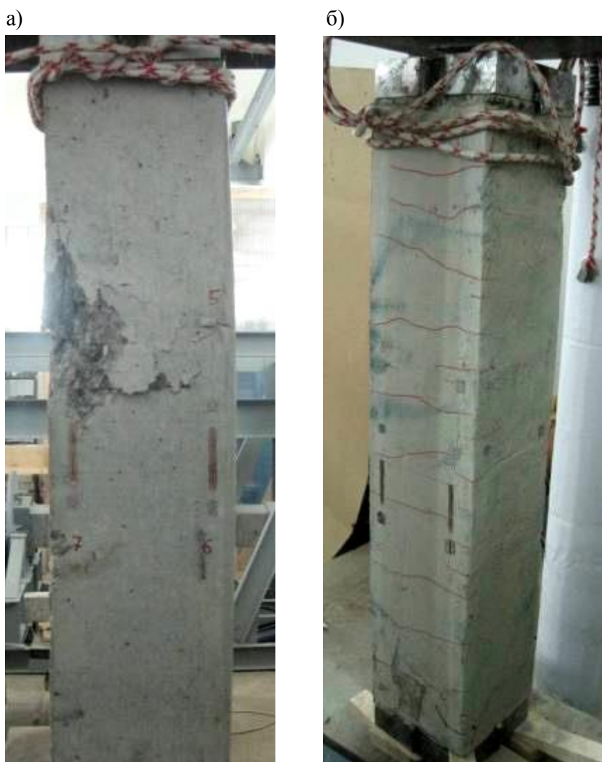
Рисунок 3.10 – Вид разрушенной железобетонной стойки, e_x = 4 см, e_y = 5 см а) сжатая зона; б) растянутая зона
