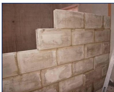
Рисунок 15 – Монтаж перегородки
