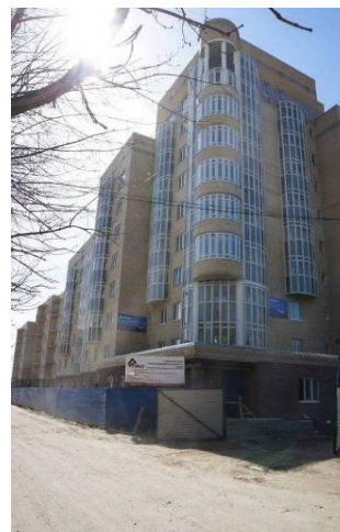
Рисунок 51 - Жилые дома с перегородками из фибропенобетона
