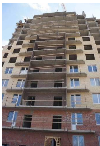
Рисунок 50 - Жилые дома с перегородками из фибропенобетона
