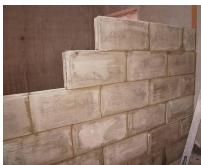
Рисунок 48 - Монтаж перегородки
