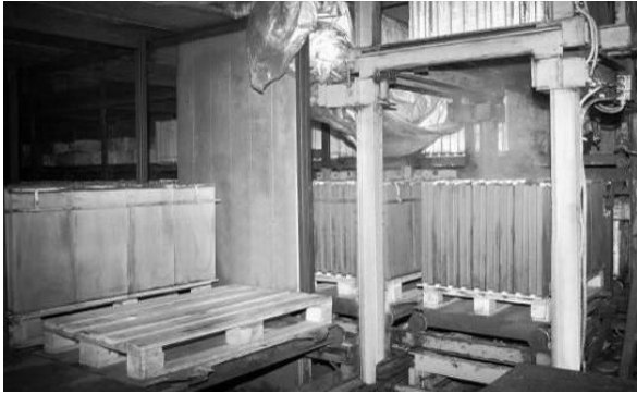
Рисунок 39 - Автомат для распалубки форм
