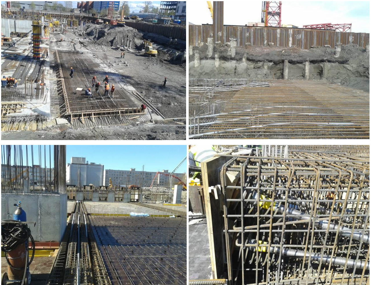
Рисунок 1.4 - Укладка гофрированных труб для канатов постнапряжения на объекте «Охта Молл» в Санкт-Петербурге
