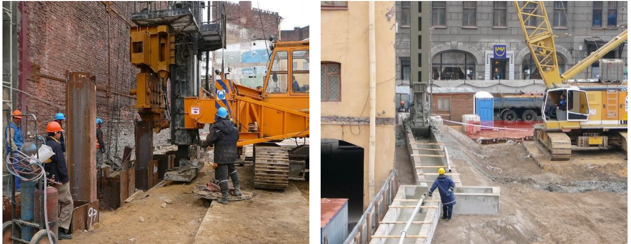
Рисунок 1.2 - Погружения шпунта и устройства «стены в грунте» возле существующих зданий на объекте «Стокманн Невский Центр» в Санкт-Петербурге
