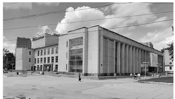
Вид на здание ДК Калужского машиностроительного завода
